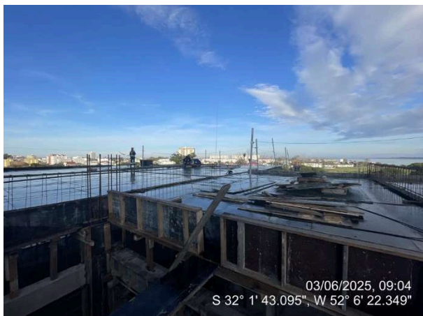
- Formas das Lajes (cobertura Ala Sul);
