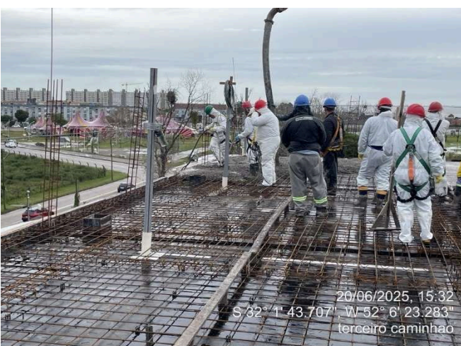
- Concretagem (Cobertura Ala Sul);
