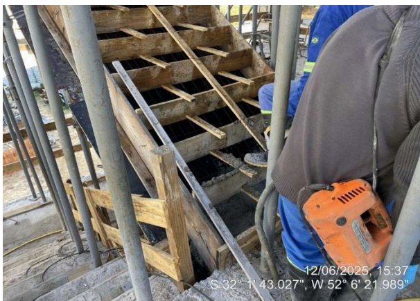
-Concretagem escadas;
