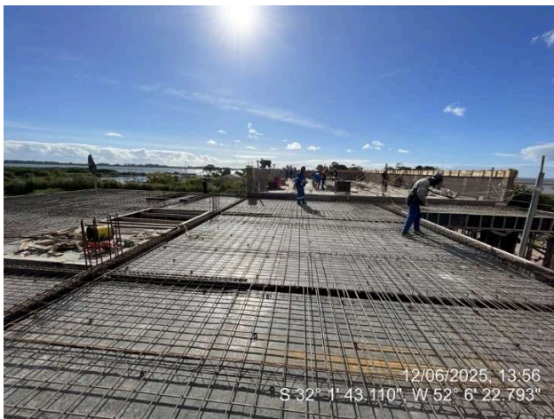
- Armação Lajes e Vigas (Cobertura Ala Sul);
