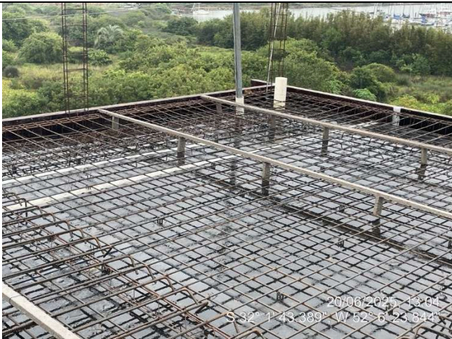
- Armação das lajes (Cobertura Ala Sul);
