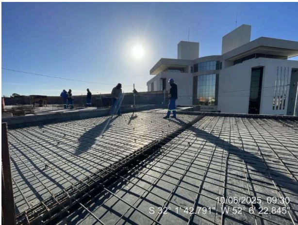
- Armação Lajes e Vigas (Cobertura Ala Sul);
