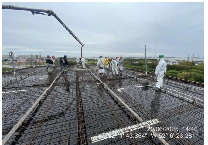
- Concretagem (Cobertura Ala Sul);
