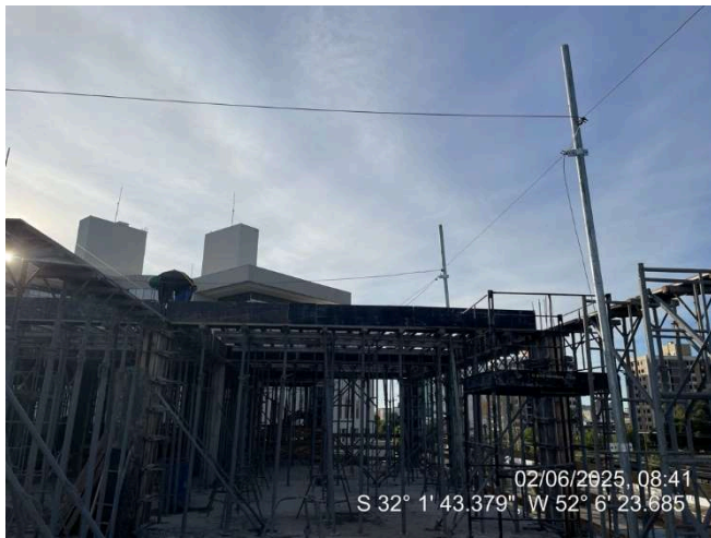
-Formas das vigas (cobertura Ala Sul);
