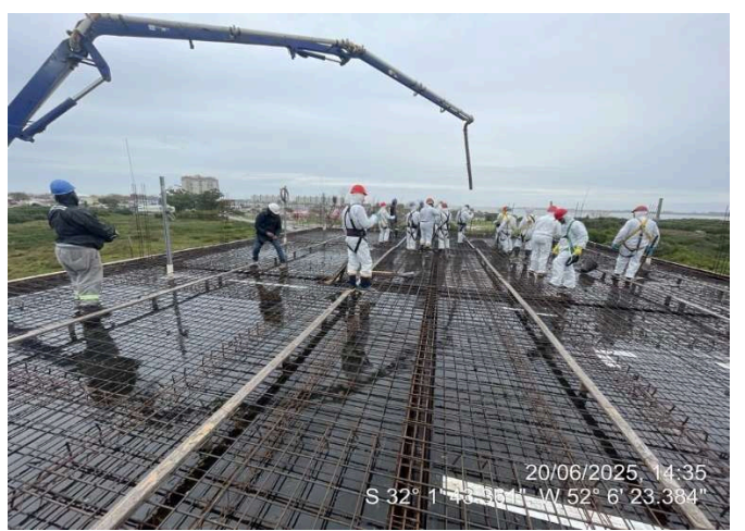
- Concretagem (Cobertura Ala Sul);
