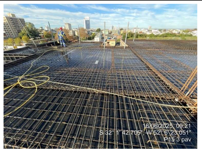
- Armação das lajes (Cobertura Ala Sul);
