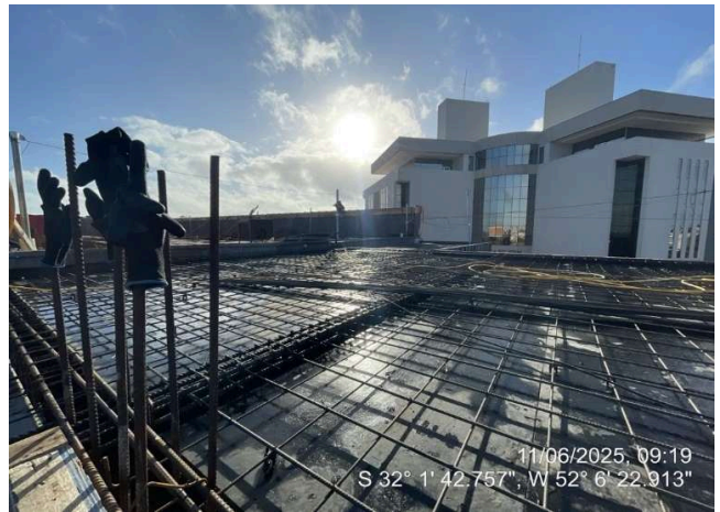
Armação Lajes e Vigas (Cobertura Ala Sul);
