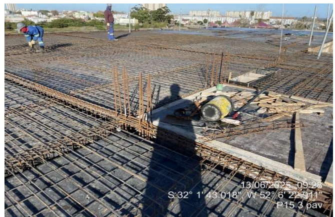
Armação Lajes e Vigas (Cobertura Ala Sul);
