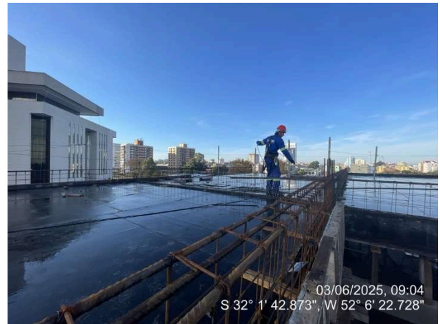
-Formas das Lajes (cobertura Ala Sul);
