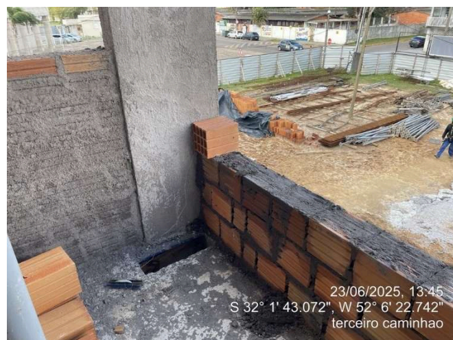
- Alvenaria (2º Pavimento Ala Sul);
