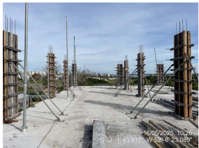
- Fôrmas Pilares (3º pav. Ala Sul);
