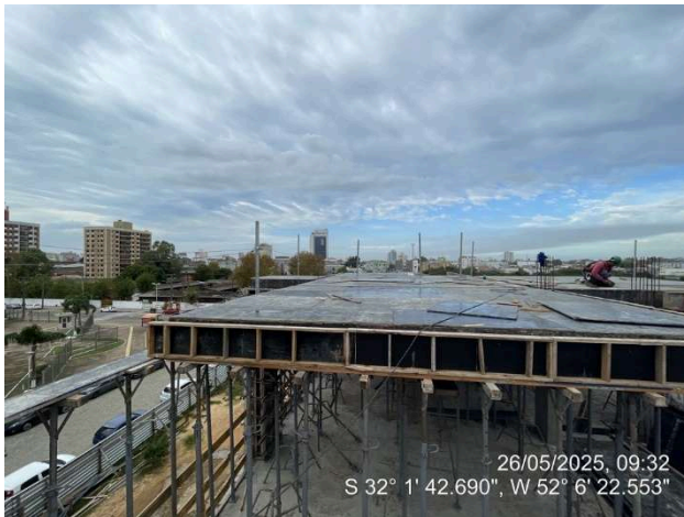
- Fôrmas Lajes (3º pav. Ala Sul);
