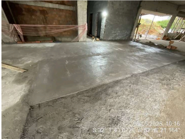
- Contrapiso (Térreo Ala Sul);
