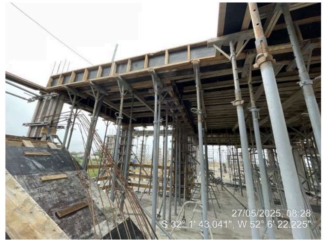
- Fôrmas Lajes e Vigas (3º pav. Ala Sul);
