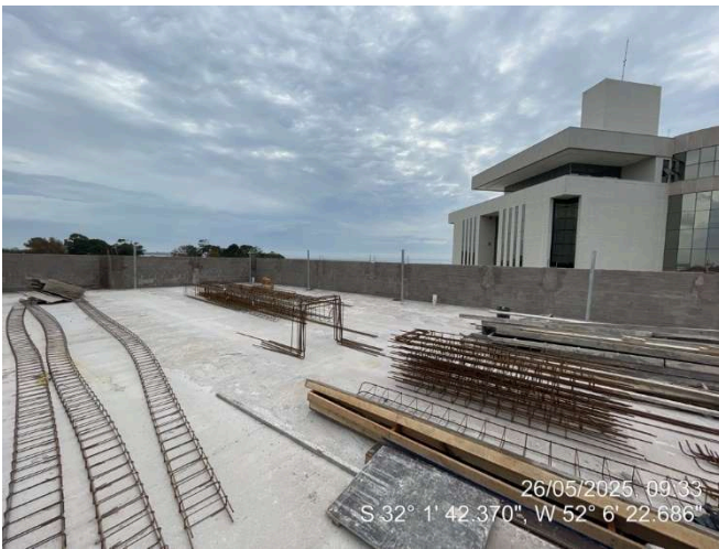
- Armação da Cinta de amarração (Platibanda);
