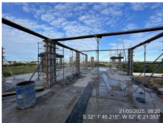
- Fôrmas Vigas (3º pav. Ala Sul);
