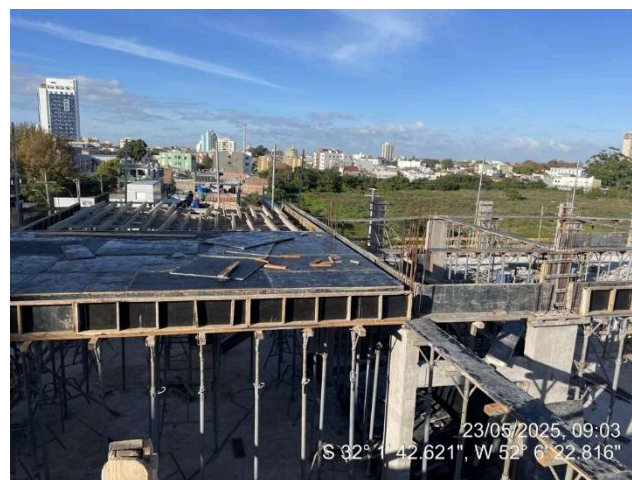
- Fôrmas Lajes (3º pav. Ala Sul);
