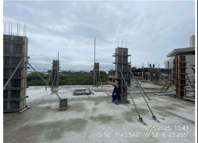
- Fôrmas Pilares (3º pav. Ala Sul);
