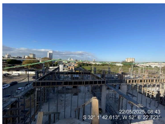
- Fôrmas Vigas (3º pav. Ala Sul);
