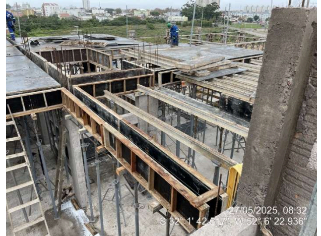
-Fôrmas Vigas (3º pav. Ala Sul);
