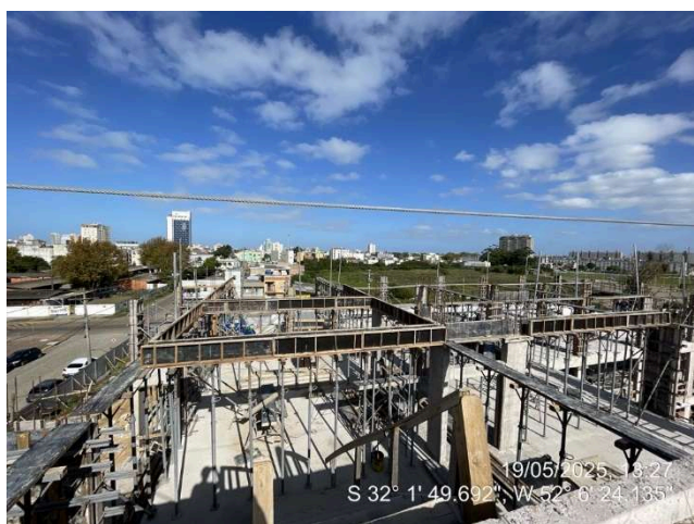
- Fôrmas Vigas (3º pav. Ala Sul);
