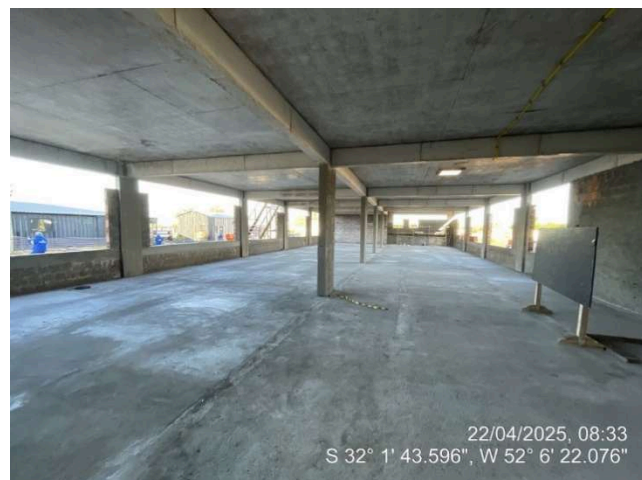
- Contrapiso (Térreo Ala Sul);
