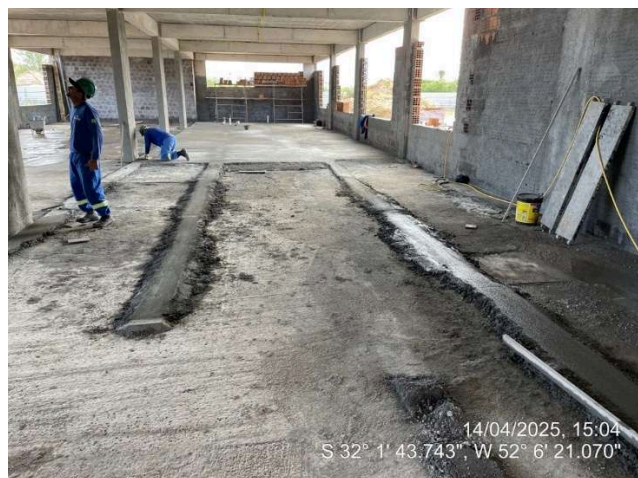
- Contrapiso (Térreo Ala Sul);
