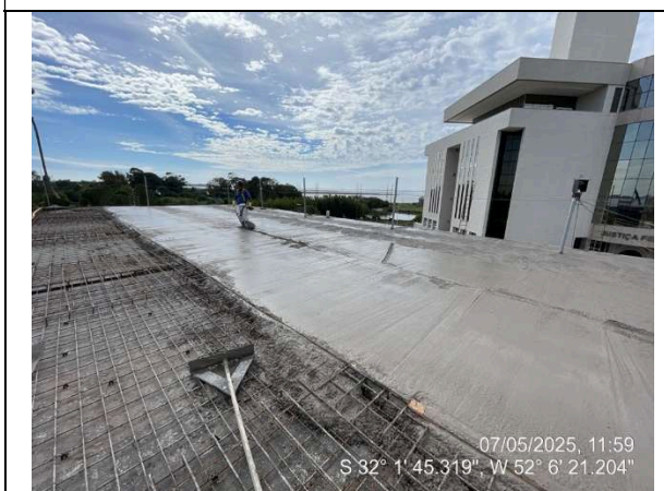
- Concretagem da laje de cobertura (Ala Leste);
