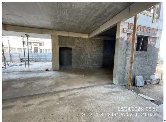
Contrapiso (Térreo Ala Sul);
