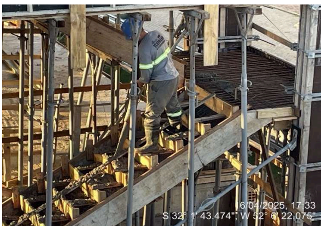
Concretagem Escada 01;
