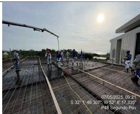
- Concretagem da laje de cobertura (Ala Leste);
