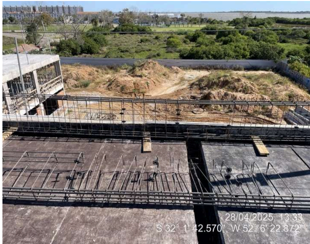
- Armação Vigas (Cobertura Ala Leste);
