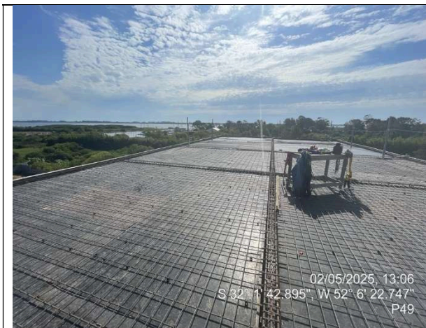
- Colocação das Armaduras Positivas (Cobertura Ala Leste);
