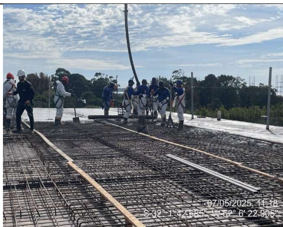
- Concretagem da laje de cobertura (Ala Leste);
