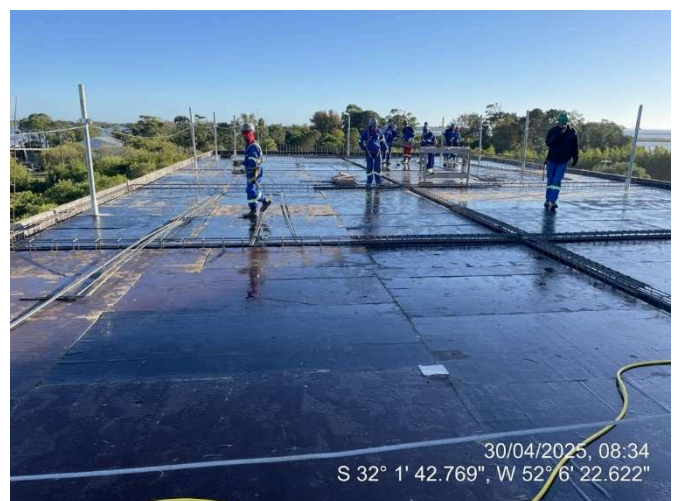
- Colocação das Armaduras Positivas (Cobertura Ala Leste);
