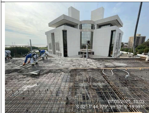
- Concretagem da laje de cobertura (Ala Leste);
