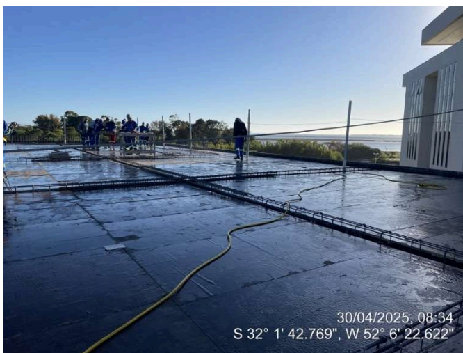
- Colocação das Vigas (Cobertura Ala Leste);
