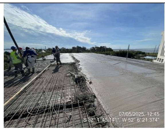
- Concretagem da laje de cobertura (Ala Leste);
