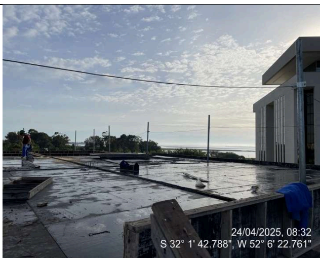
Fôrmas Vigas (Cobertura Ala Leste);
