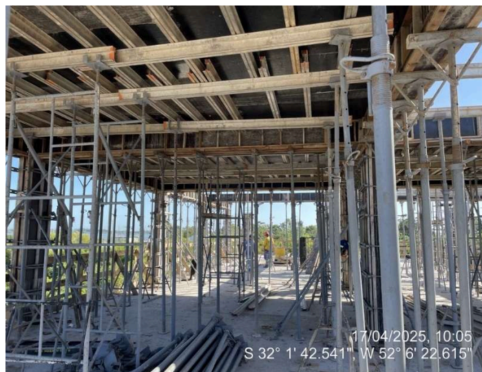
- Fôrmas Lajes (Cobertura Ala Leste);
