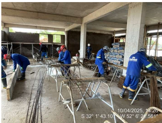
- Armação Pilares (Platibanda);
