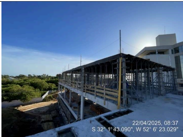
Fôrmas Lajes (Cobertura Ala Leste);
