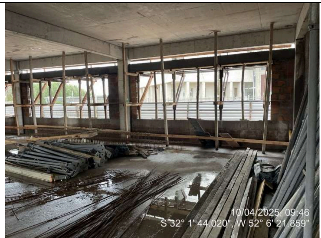
- Concretagem Vergas (Térreo);
