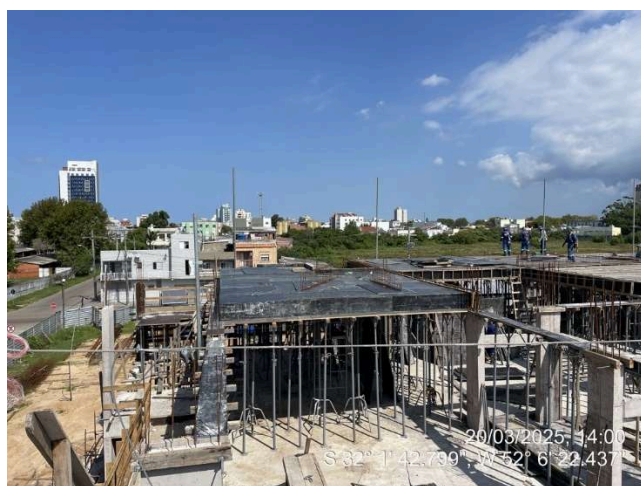
Formas Vigas (3º Pav Ala Sul);
