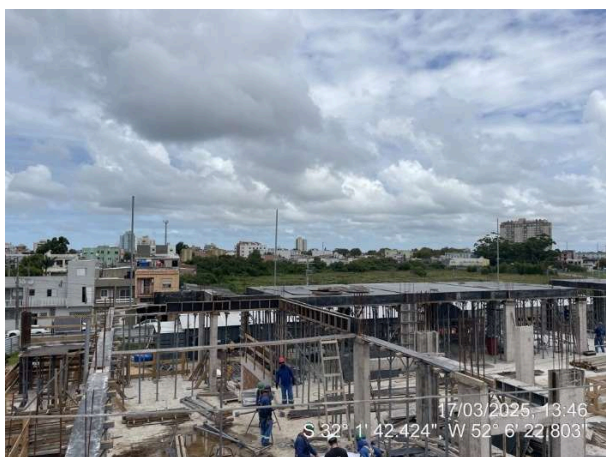
- Formas Vigas (3º Pav Ala Sul);
