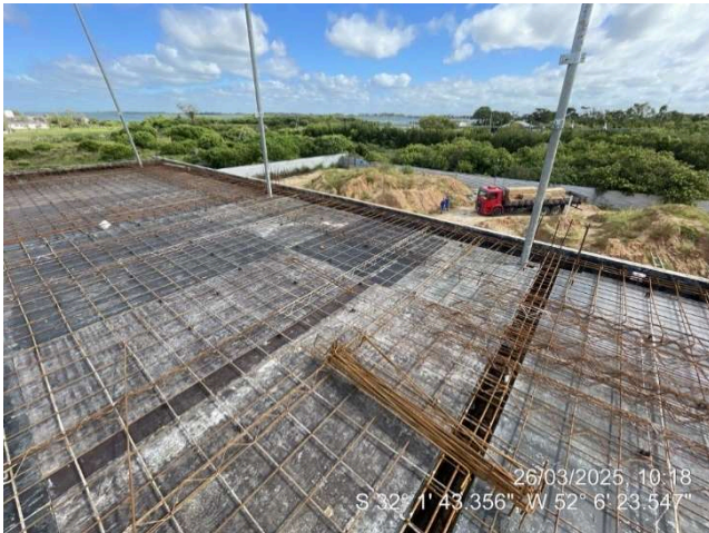
Armação Vigas e Lajes (3º Pavimento Ala Sul);
