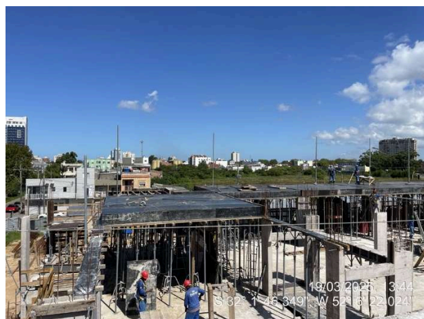
Formas Vigas e Lajes (3º Pav Ala Sul);
