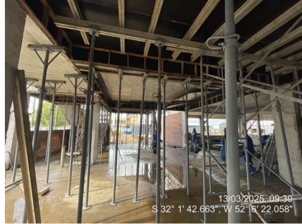
Desforma Vigas e Lajes (2º Pavimento Ala Sul);
