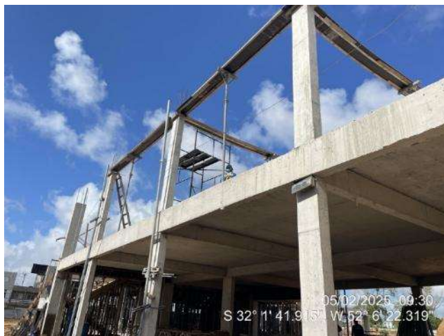
- Formas Vigas (3º Pav Ala Leste);
