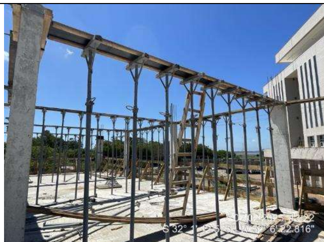
- Formas Vigas (3º Pav Ala Leste);
