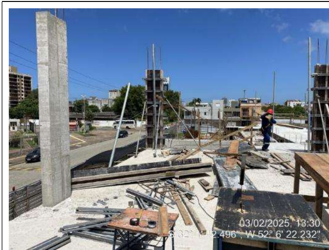
- Desforma dos pilares do 2º Pav Ala Leste;
