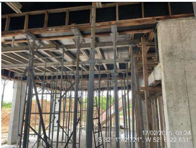
- Formas das Lajes (3º Pav. Ala Leste);
