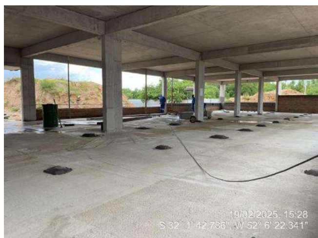
-Contrapiso Ala Leste (Térreo)
