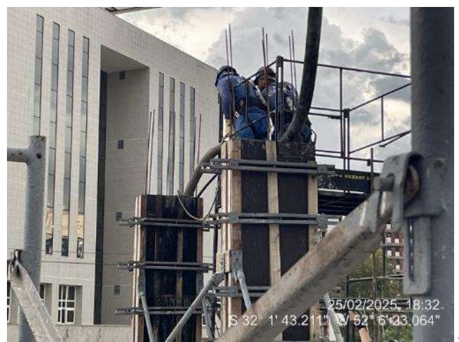
Concretagem dos Pilares ( 2º Pav Ala Sul);
