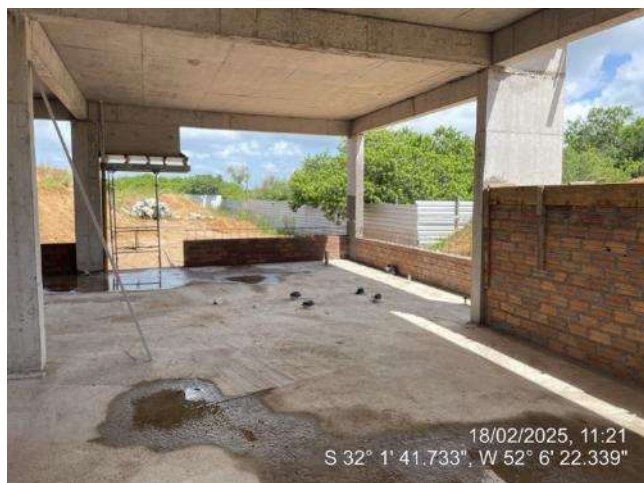
- Alvenarias (Térreo Ala Leste);
