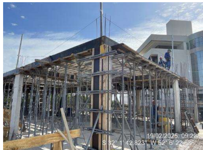
-Formas Vigas (3º Pav Ala Leste);
