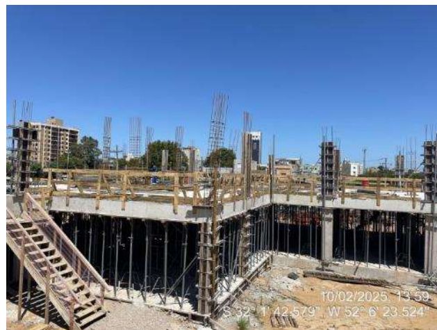
Armação Pilares (2º Pav Ala Sul);
