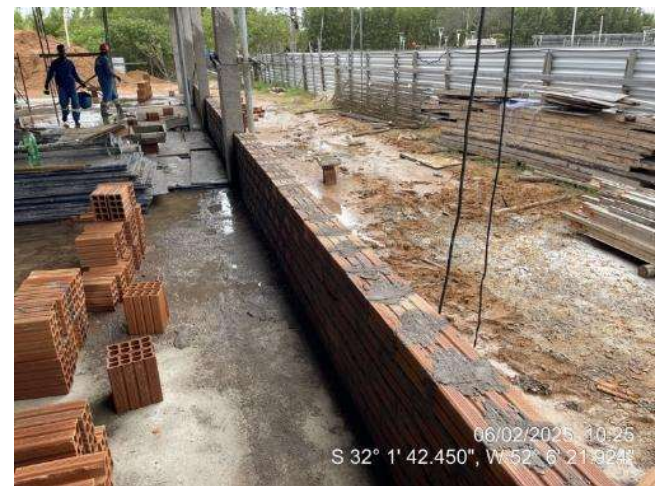
- Alvenarias (Térreo Ala Leste);
