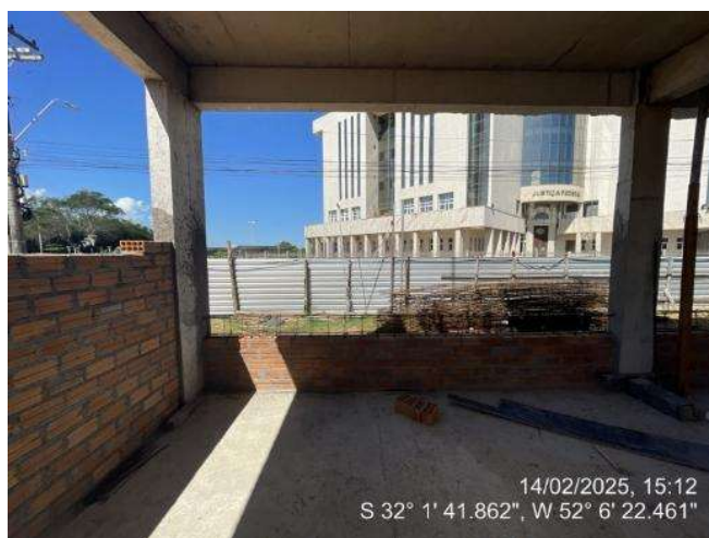
-- Alvenarias (Térreo Ala Leste);
