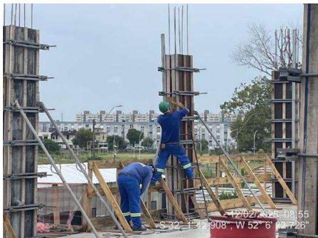
Formas das Pilares (2º Pav. Ala Sul);
