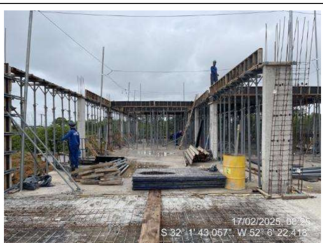
Formas Vigas (3º Pav Ala Leste);
