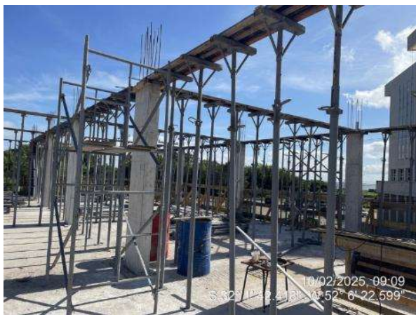
Formas Vigas (3º Pav Ala Leste);
