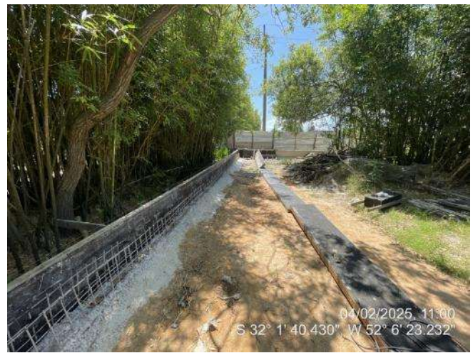
- Formas e armação do Trecho Sapata Corrida "Gradil 1";
