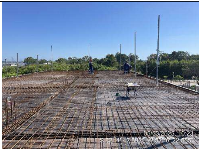
- - Armação Lajes (3º Pav. - Ala Leste);
