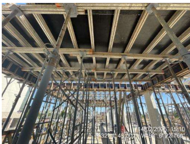
- Formas das Lajes (3º Pav. Ala Leste);
