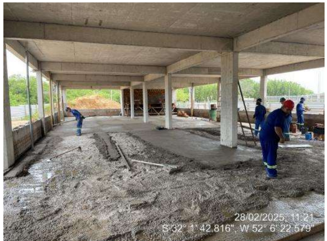
-Contrapiso Ala Leste (Térreo)
