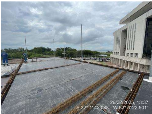
- Armação Lajes (3º Pav Ala Leste);
