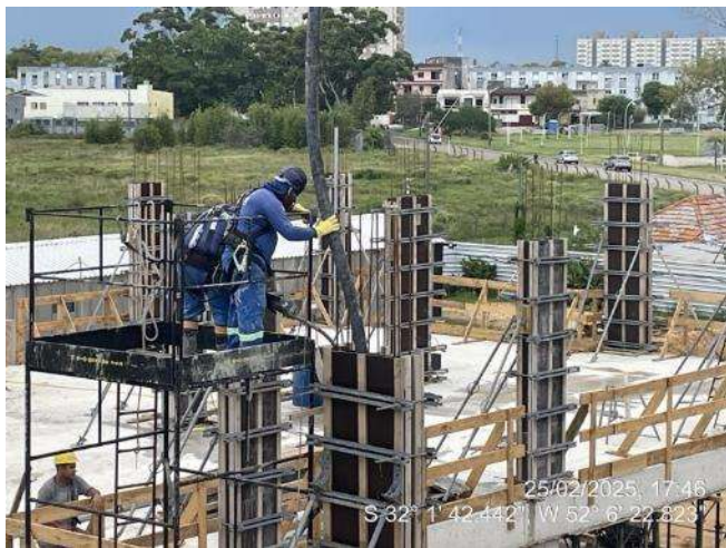
- Concretagem dos Pilares ( 2º Pav Ala Sul);
