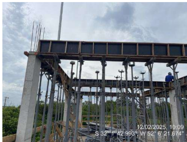
-- Formas Vigas (3º Pav Ala Leste);
