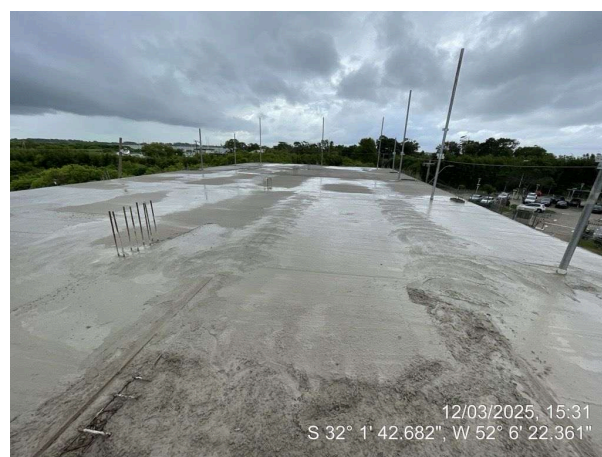
- Laje 3º Pav. Ala Leste - Concretado
