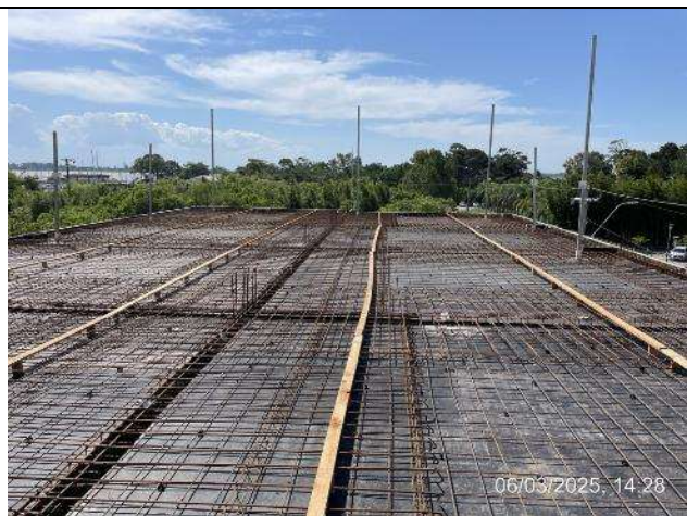
- Laje 3º Pav. Ala Leste - pronta para a concretagem
