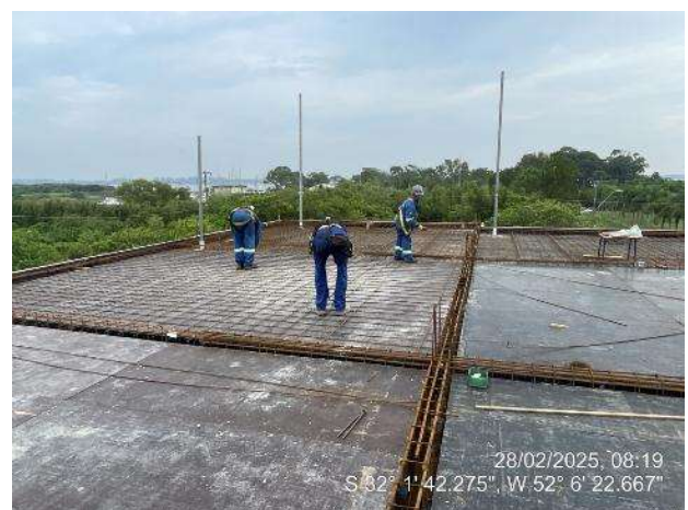
- Armação Lajes (3º Pav Ala Leste);
