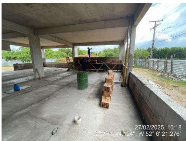
- Alvenarias (Térreo Ala Leste);
