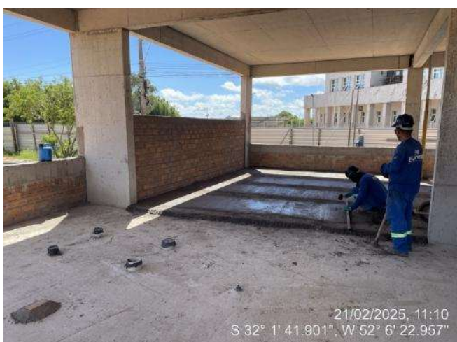
-Contrapiso Ala Leste (Térreo)
