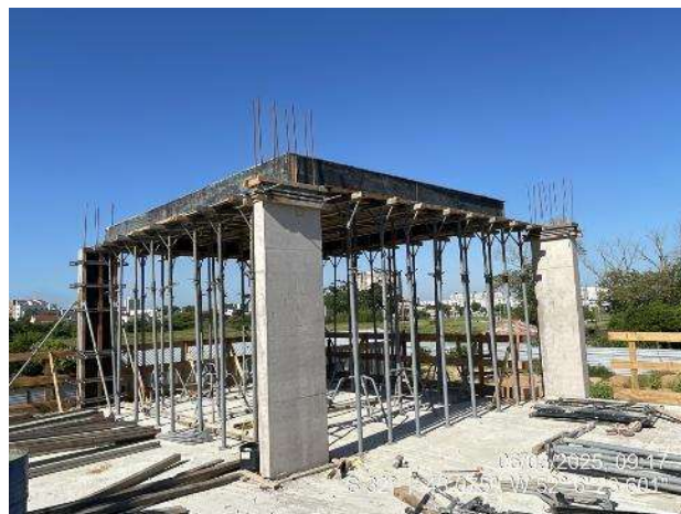
- Formas Vigas (3º Pav Ala Sul);
