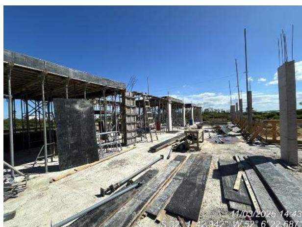
- Canteiro de obras sem colaboradores.
