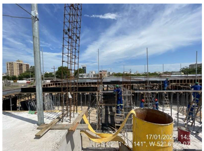
-Formas das Lajes (2º Pav. Ala Sul);
