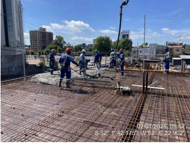
-Concretagem das Lajes da Ala Leste
