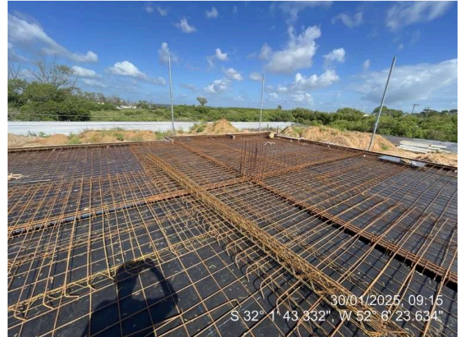
- Armação Lajes e Vigas (2º Pav Ala Sul);
