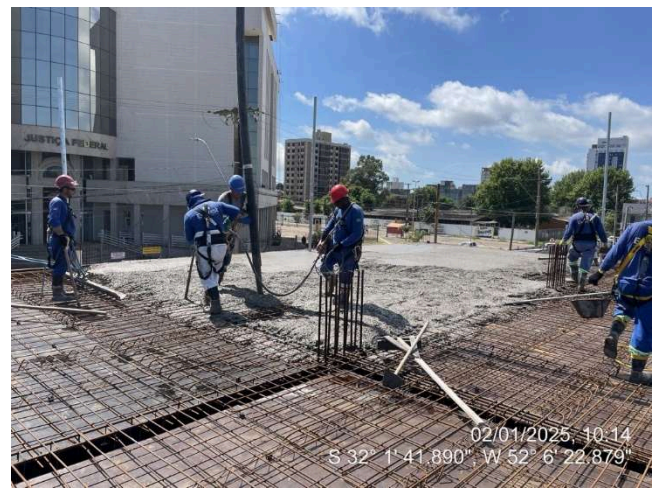
-Concretagem das Lajes da Ala Leste
