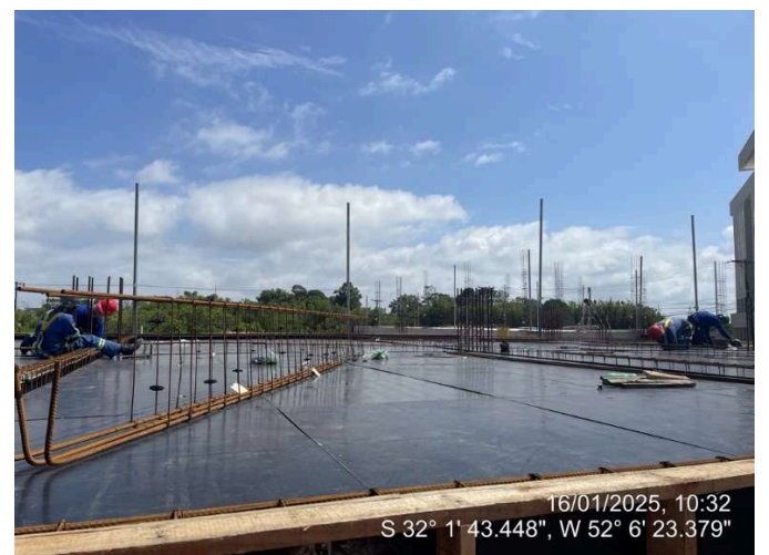
-Formas das Lajes (2º Pav. Ala Sul);
