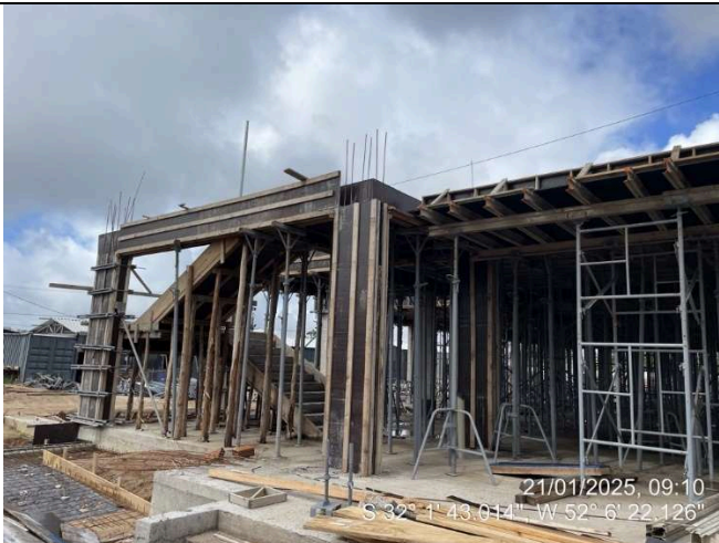
- Formas das Lajes (2º Pav. Ala Sul);
