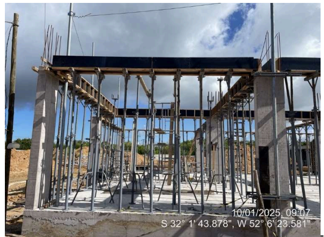
Formas das Vigas (2º Pav. Ala Sul);
