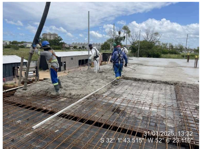
- Concretagem Lajes e Vigas (2º Pav Ala Sul);
