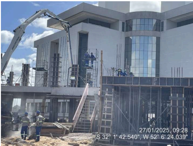
- Concretagem dos Pilares ( 2º Pav Ala Leste);
