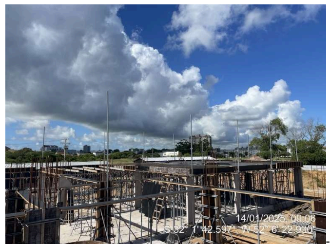
Formas das Lajes (2º Pav. Ala Sul);
