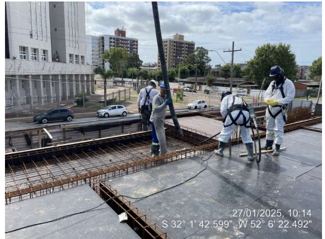
- Concretagem dos Pilares ( 2º Pav Ala Leste);
