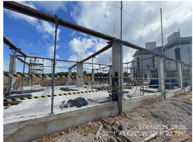
- Formas das Vigas (2º Pav. Ala Sul);
