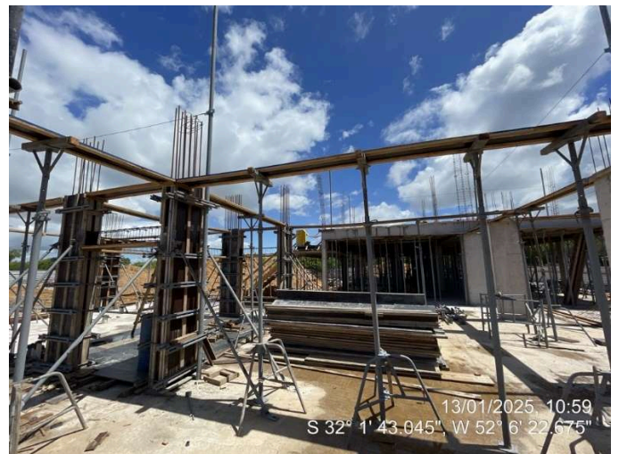
- Formas Vigas (2º Pav Ala Sul);
