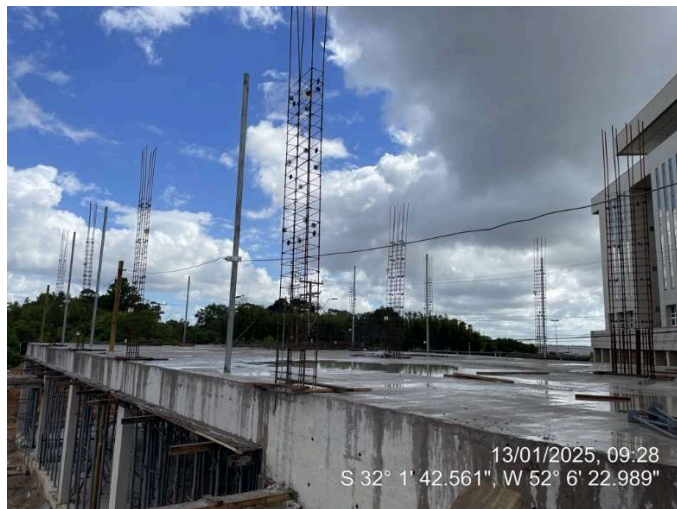
- Armação dos pilares do 2º Pav Ala Leste;
