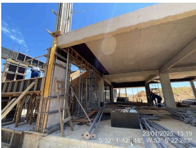
- Desforma das Lajes e Vigas do 2º Pav Ala Leste ;
