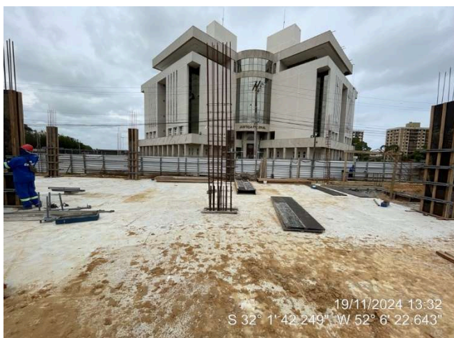
Armação Pilares (Ala Leste)
