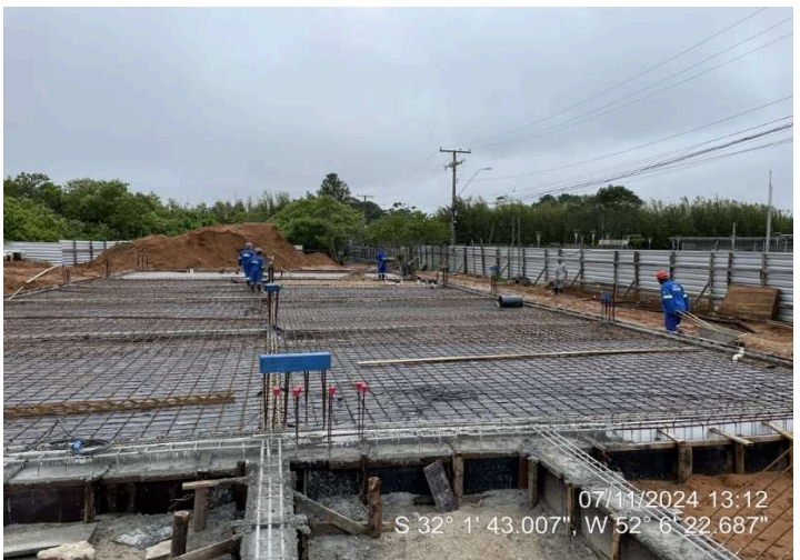
Armação das lajes do térreo ala leste;
