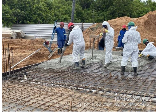
Concretagem das lajes do térreo (Ala Leste)
