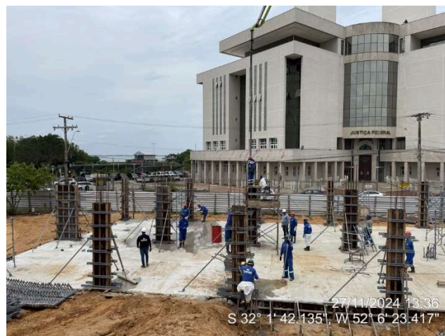
Concretagem Pilares (Térreo Ala Leste);
