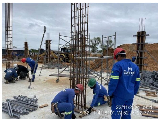
Armação Pilares (Ala Leste)
