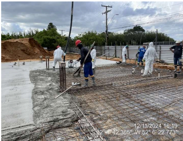
Concretagem das lajes do térreo (Ala Leste)
