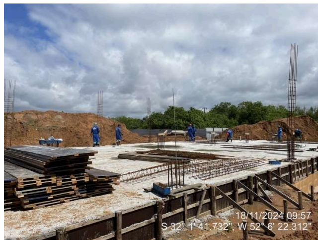
Armação Pilares (Ala Leste)
