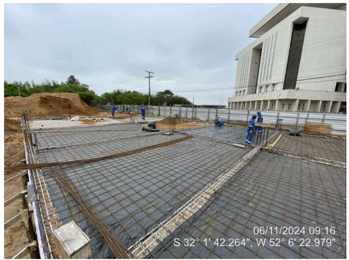
Armação das lajes do térreo ala leste;
