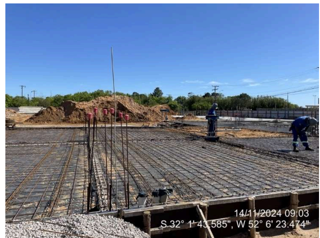
Armação das lajes do térreo (Ala Sul)
