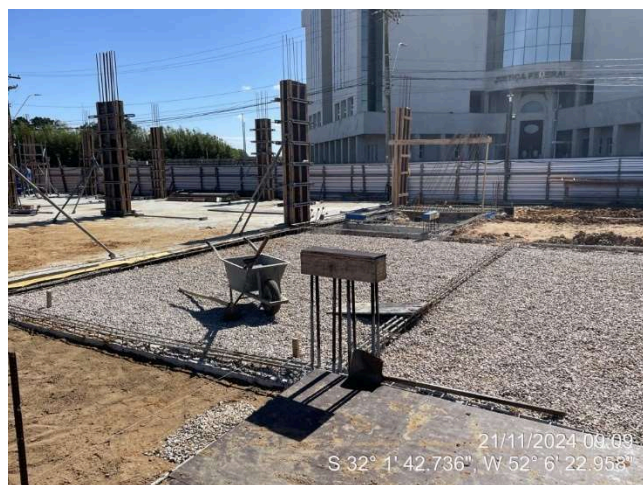
Colocação Camada Granular Lajes (Ala Sul)
