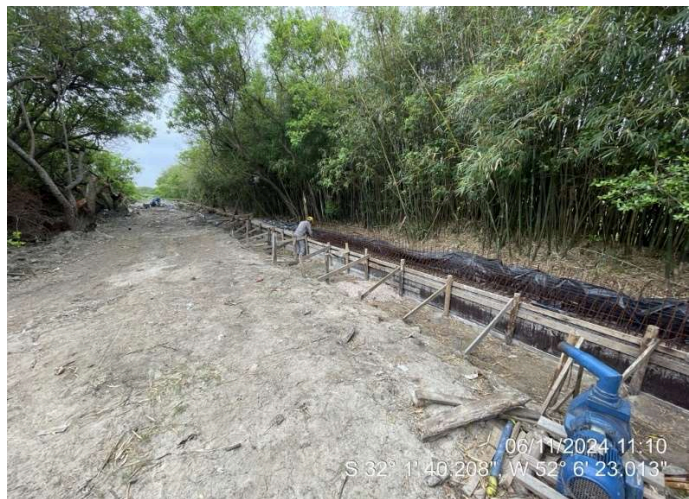
Armação - Trecho Sapata Corrida "Gradil 1";
