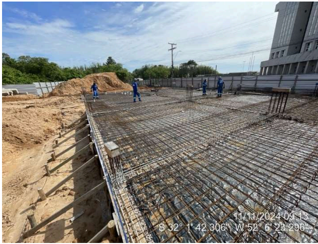
Armação das lajes do térreo (Ala Leste)
