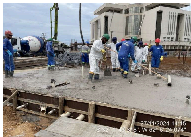
Concretagem Lajes (Térreo Ala Sul);
