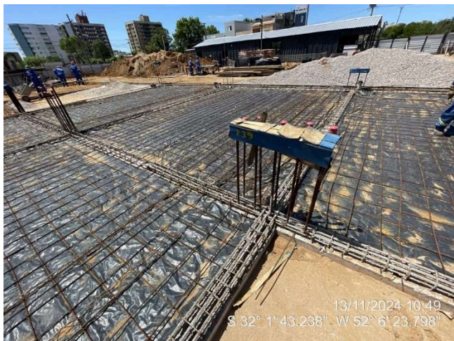
Armação das lajes do térreo (Ala Sul)
