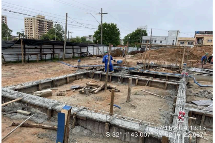
Montagem de formas e armaduras das vigas do elevador
