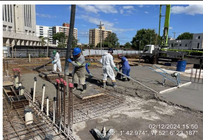
Concretagem Lajes (Térreo Ala Sul);
