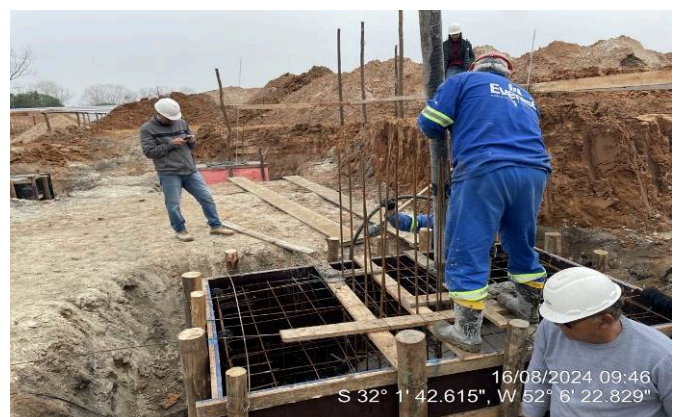
-Concretagem dos blocos de fundação
