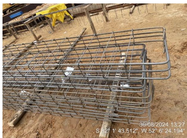
- Montagem das armaduras das vigas de fundações
