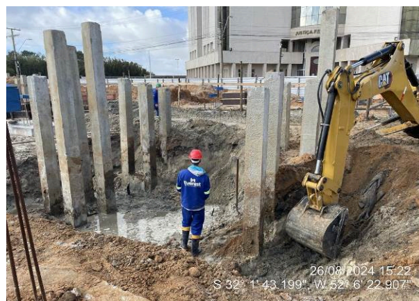
- Escavação do poço do elevador
