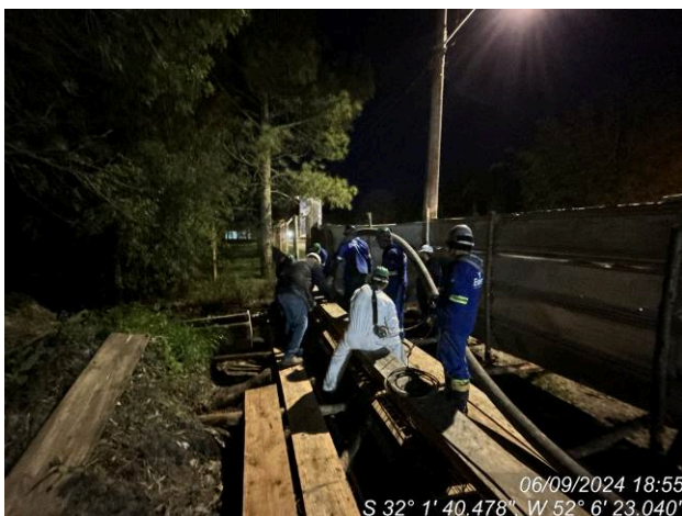
- Concretagem do trecho sapata corrida
