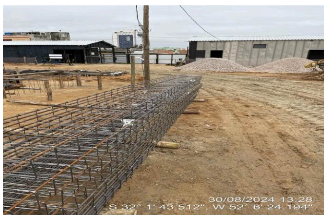
- Montagem das armaduras das vigas de fundações
