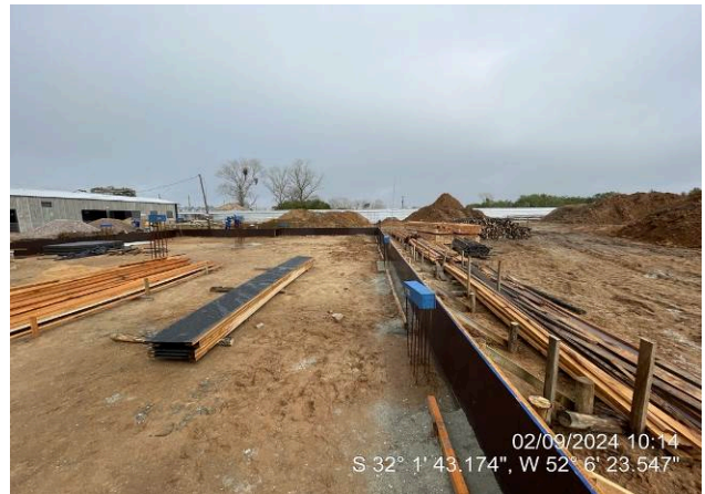
- Montagem de formas das vigas de fundação
