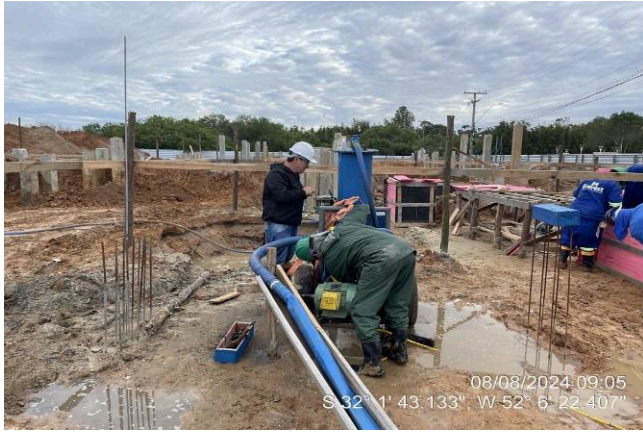
-Rebaixamento do lençol freático
