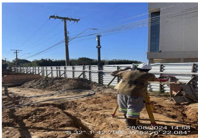
- Marcação de eixos e meio fio pela topografia
