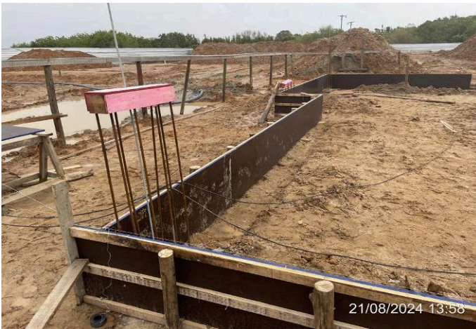
-Montagem de formas das vigas de fundação
