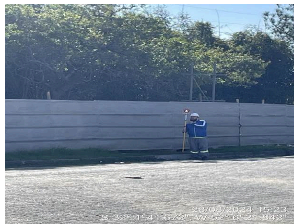
- Marcação de eixos e meio fio pela topografia
