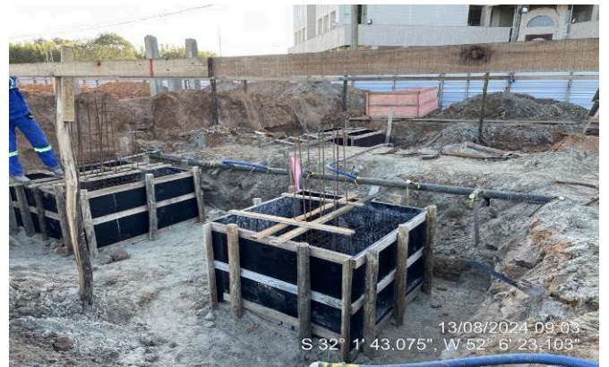
- Montagem de formas e armaduras dos blocos de fundação
