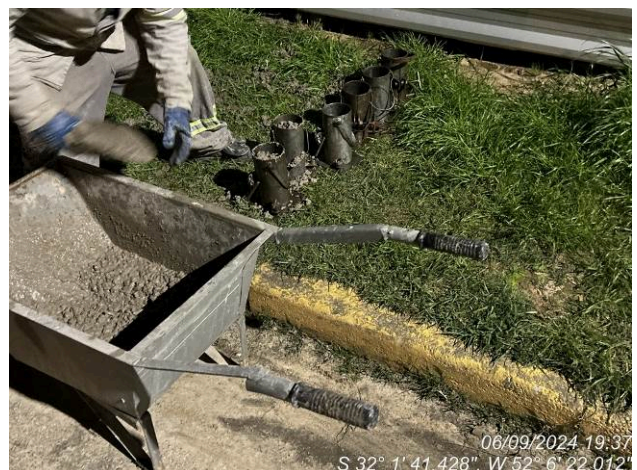
- Controle tecnológico do concreto
