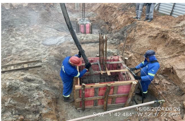
-Concretagem dos blocos de fundação
