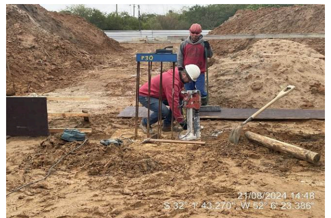
- Extração de corpos de provas dos blocos de fundação
