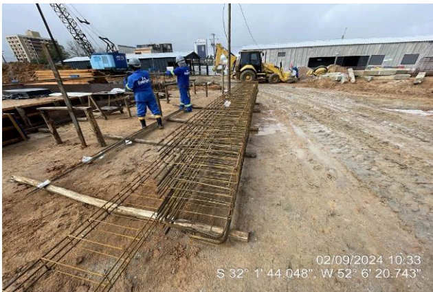
- Montagem das armaduras das vigas de fundações
