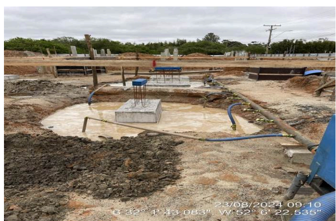
- Rebaixamento do lençol freático
