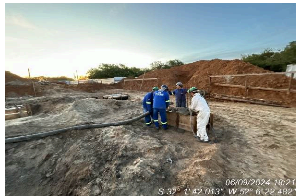
- Concretagem dos blocos de fundações
