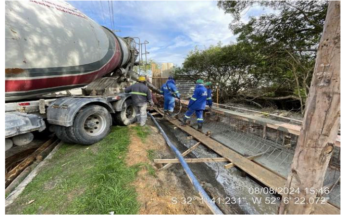
-Concretagem do trecho sapata corrida gradil 5
