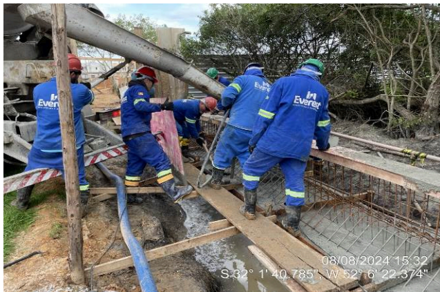
-Concretagem do trecho sapata corrida gradil 5
