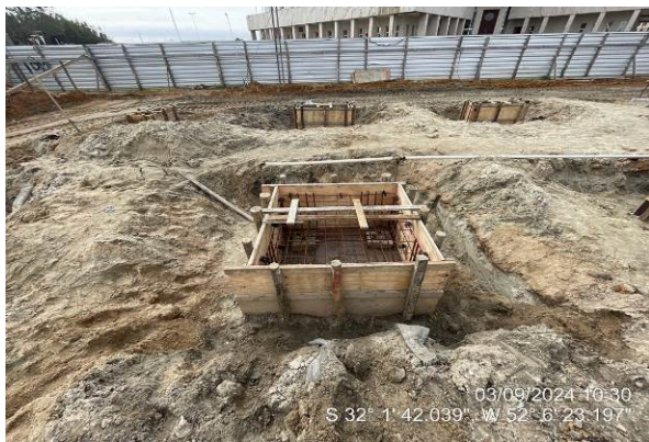
- Montagem de formas e armaduras dos blocos de fundação
