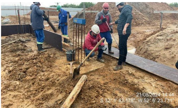
- Extração de corpos de provas dos blocos de fundação
