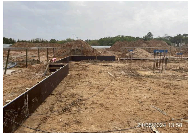
-Montagem de formas das vigas de fundação
