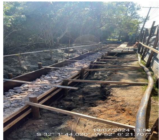
Colocação de rachão na estrutura de sapata corrida
