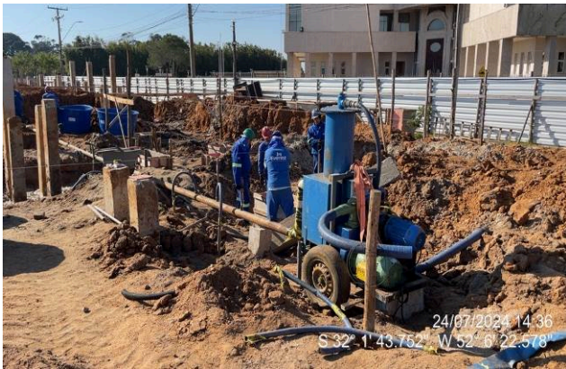
Colocação de armaduras e arranques de pilares
