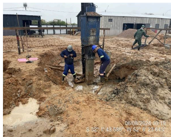
Cravação de estacas – últimas estacas
