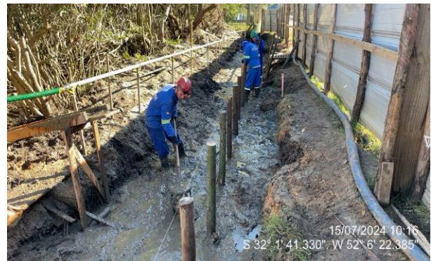
Rebaixamento do lençol freático
