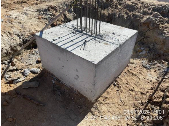
Desforma blocos
