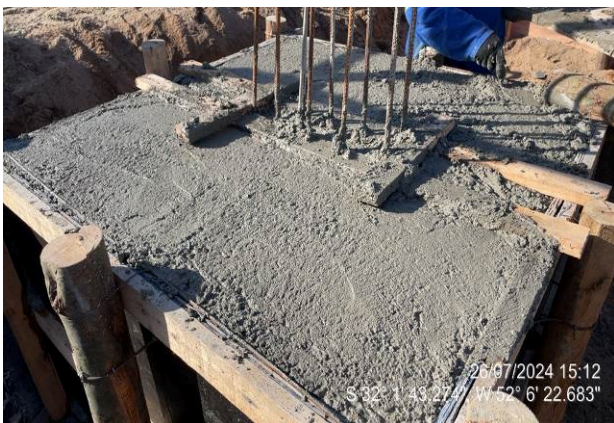
Bloco concretado
