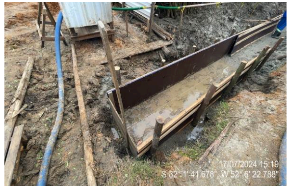
Estrutura do trecho sapata corrida gradil 5.
