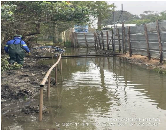
Rebaixamento do lençol freático
