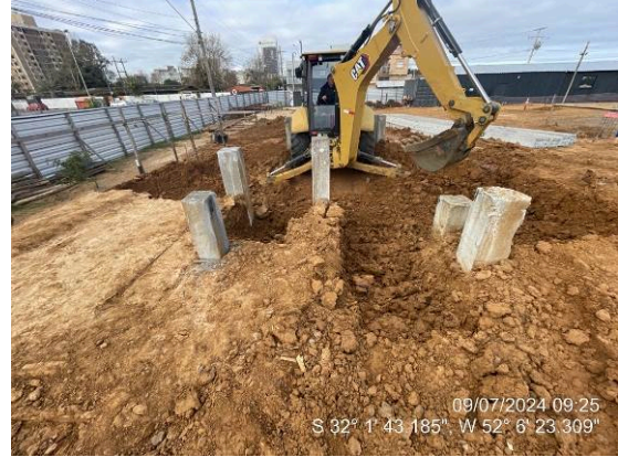
Escavação em torno das estacas para os blocos de fundação
