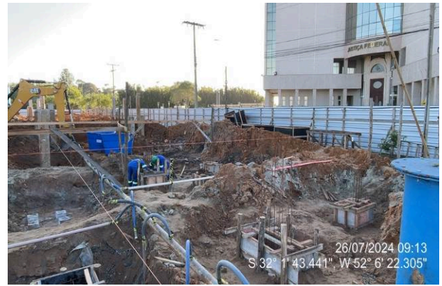
Montagem das formas para os blocos de fundação
