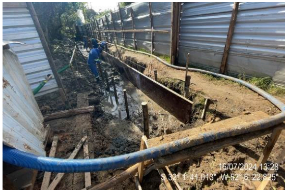
- Estrutura do trecho sapata corrida gradil 5.
