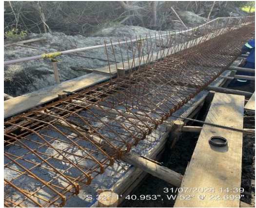
Armaduras sapata corrida
