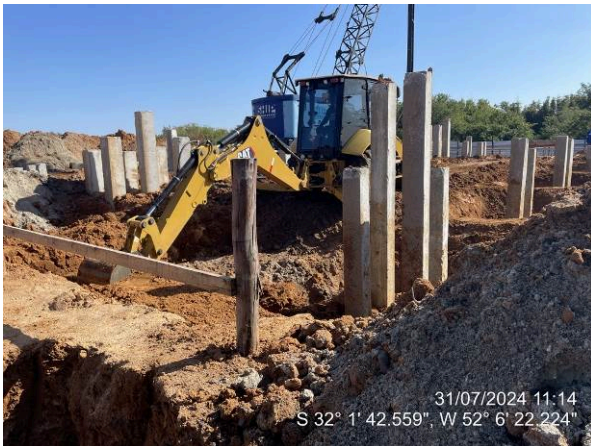
Escavação para arrasamento das estacas
