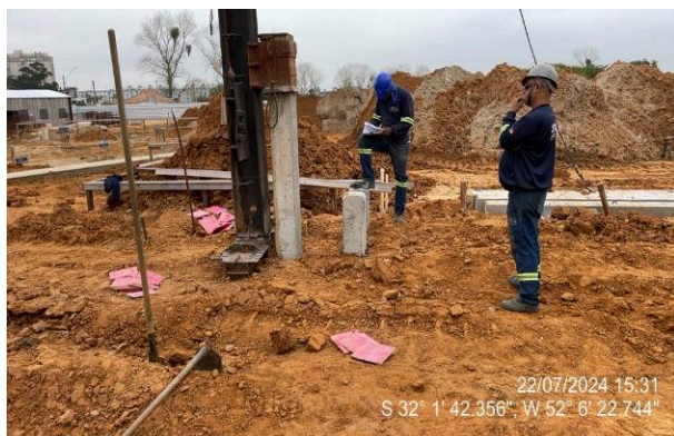
Cravação de estacas
