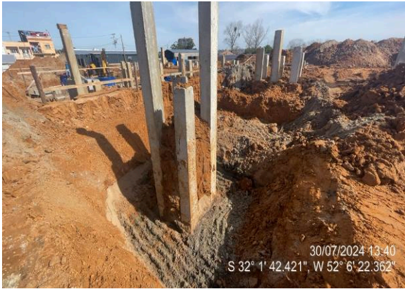
Escavação para arrasamento das estacas
