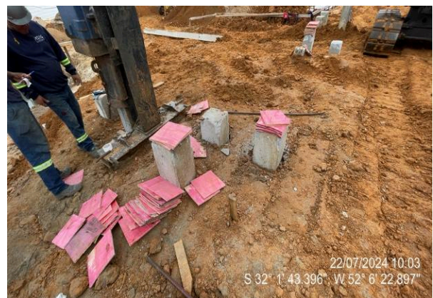
Cravação de estacas
