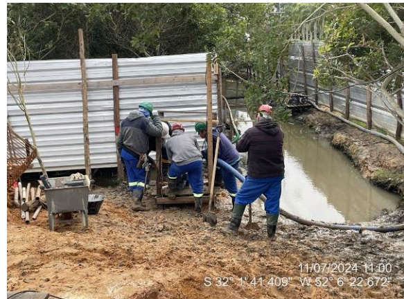
Rebaixamento do lençol freático
