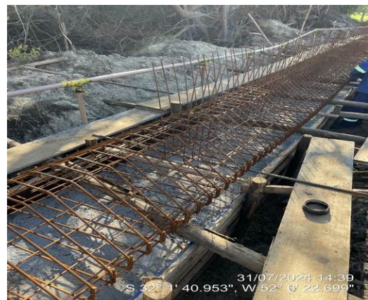
Estrutura de ferragem do Gradil 5
