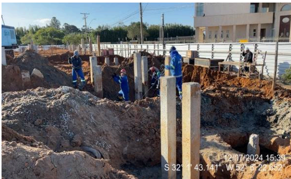
Escavação em torno das estacas para os blocos de fundação
