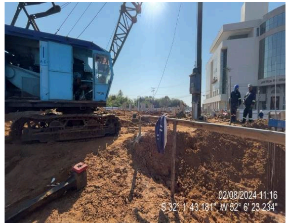
Cravação de estacas
