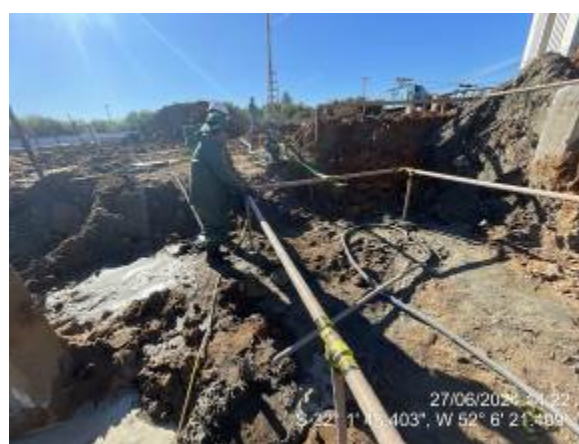
Rebaixamento do lençol freático
