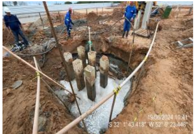
Rebaixamento do lenço freático
