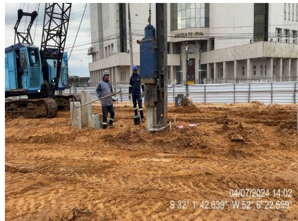
Cravação de estacas
