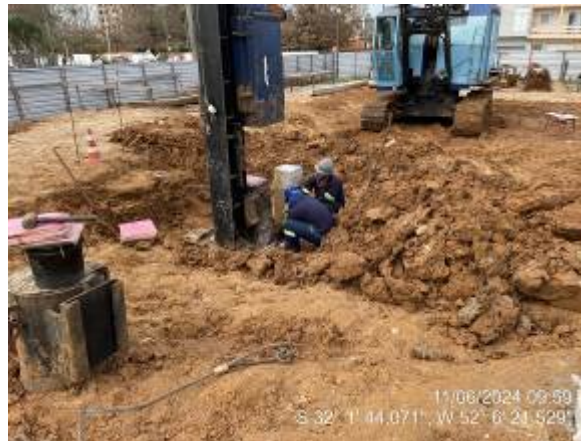
Cravação de estacas
