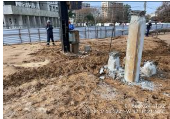
Cravação de estacas
