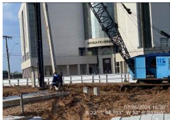
Cravação de estacas
