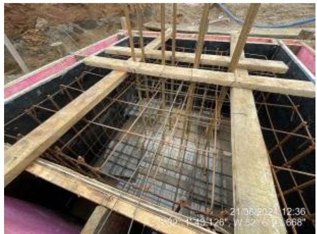
Colocação de armaduras e arranques de pilares
