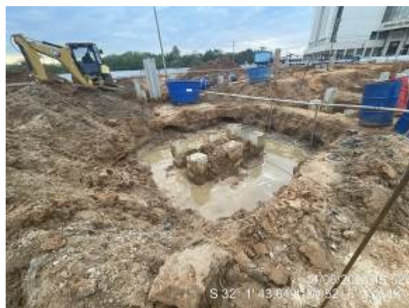
Rebaixamento do lençol freático
