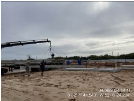
Chegada de estacas no canteiro
