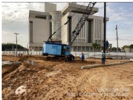
Cravação de estacas
