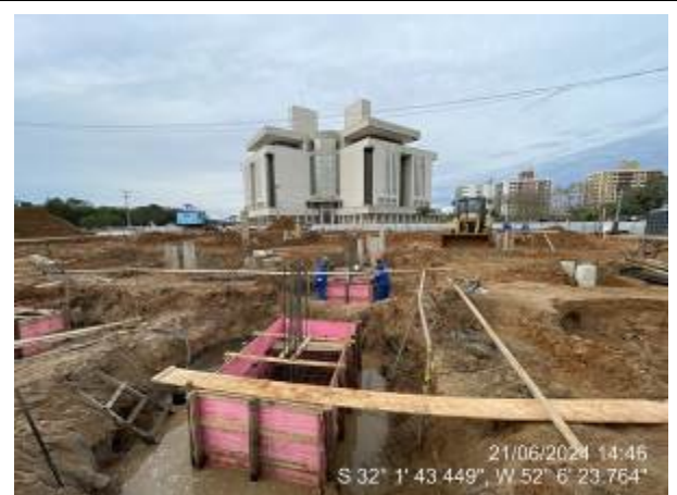
Colocação de armaduras e arranques de pilares
