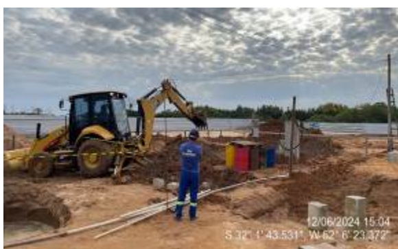
Escavação das valas dos blocos
