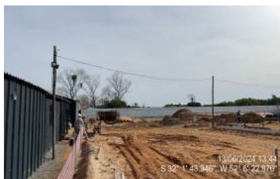
Marcação das estacas
