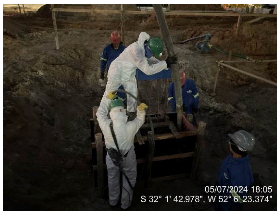
Concretagem dos blocos de fundações
