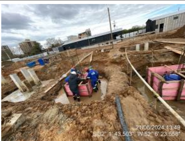
Colocação de armaduras e arranques de pilares
