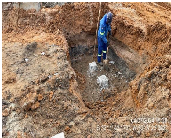
Arrasamento de estacas
