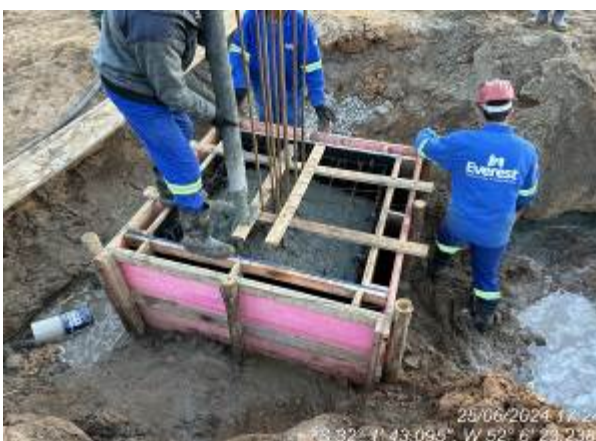
Concretagem dos blocos de fundações
