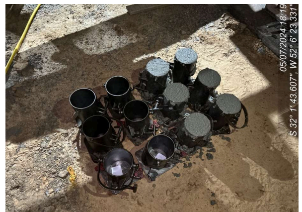
Controle tecnológico do concreto
