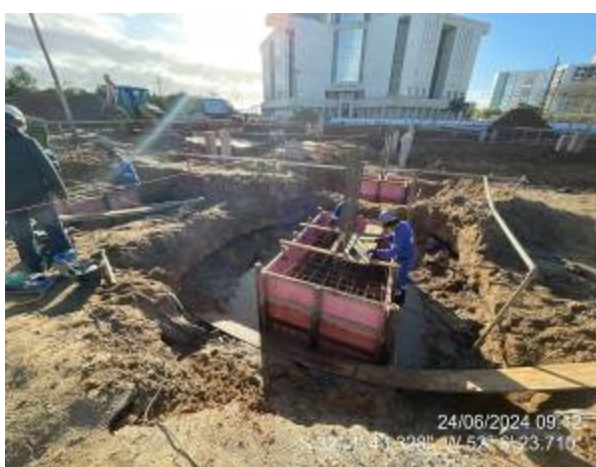
Colocação de armaduras e arranques de pilares
