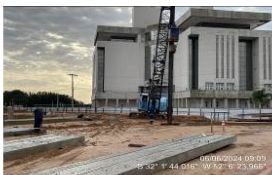
Cravação de estacas
