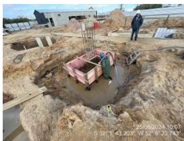
Tentativa de retirada da água do fundo da forma
