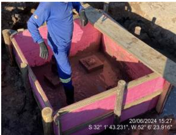
Colocação de formas e lastro
