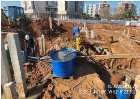
Rebaixamento do lenço freático
