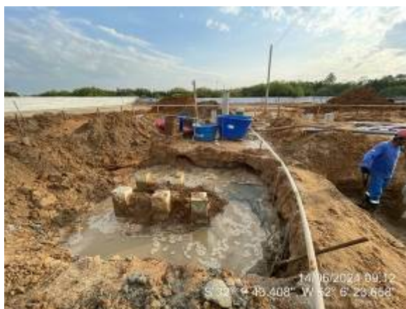
Rebaixamento do lençol freático
