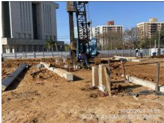
Cravação de estacas
