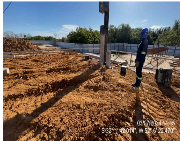
Cravação de estacas
