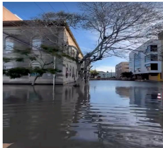
Situação das ruas próximas à obra no dia 27/052024
