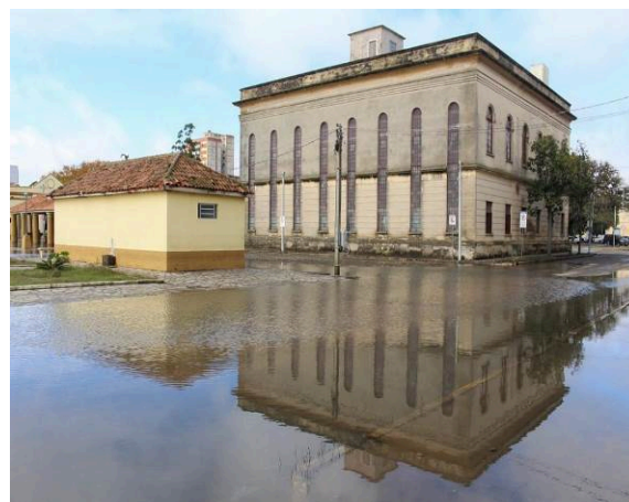
Situação das ruas próximas à obra no dia 27/052024
