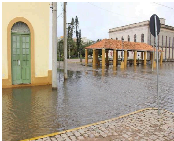
Situação das ruas próximas à obra no dia 27/052024
