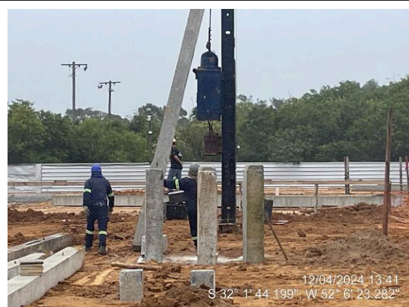
Cravação das estacas
