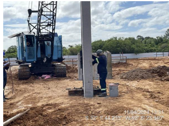
Cravação das estacas
