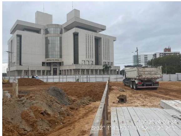
Execução do aterro de sobrecarga
