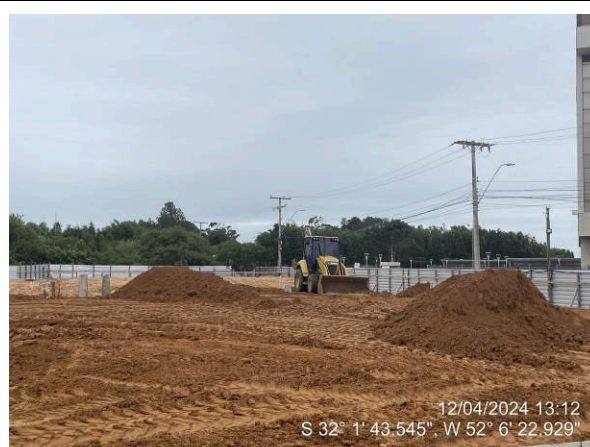
Execução do aterro de sobrecarga
