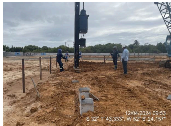
Cravação das estacas
