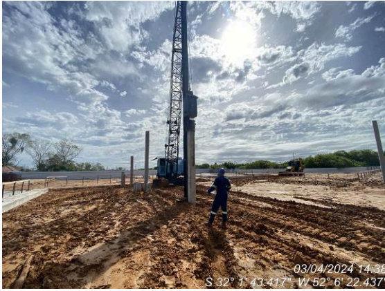
Cravação das estacas
