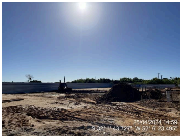
Execução do aterro de sobrecarga
