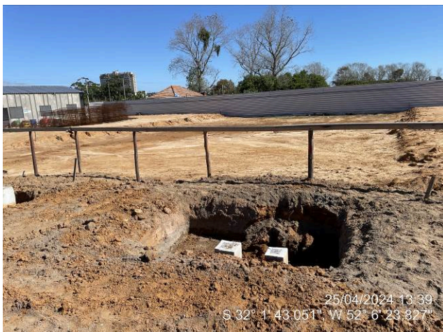
Escavação Blocos de Fundação
