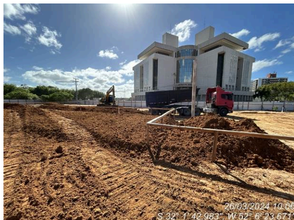
Execução do aterro de sobrecarga
