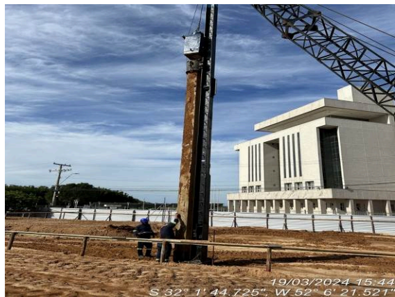
Execução de teste para verificar nega das estacas pós tempo de repouso
