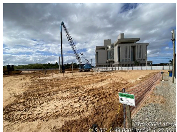
Geral canteiro – estaqueamento paralisado
