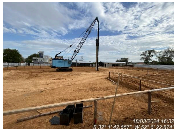
Execução do estaqueamento paralisada
