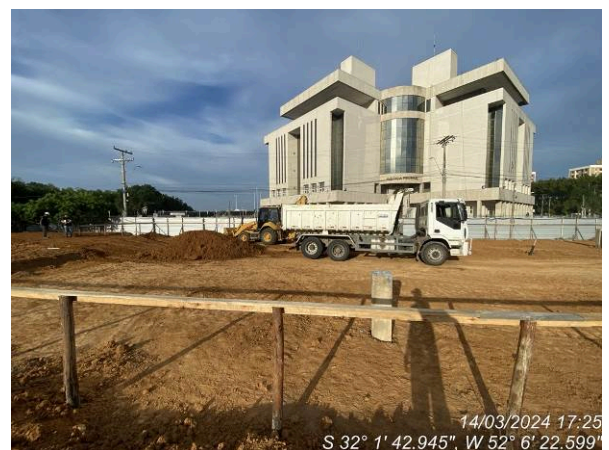
Execução do aterro de sobrecarga
