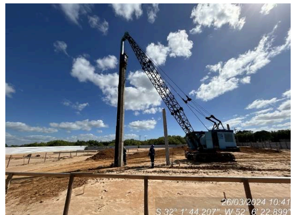
Estaqueamento - Teste para verificar nega das estacas sem tempo de repouso
