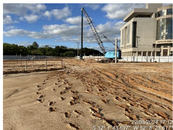
Geral canteiro – aterro de sobrecarga e estaqueamento paralisados
