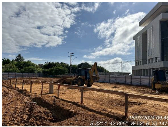
Execução do aterro de sobrecarga
