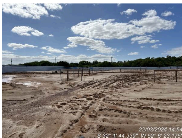
Geral canteiro – execução prejudicada pós 2 dias com ocorrência de chuva
