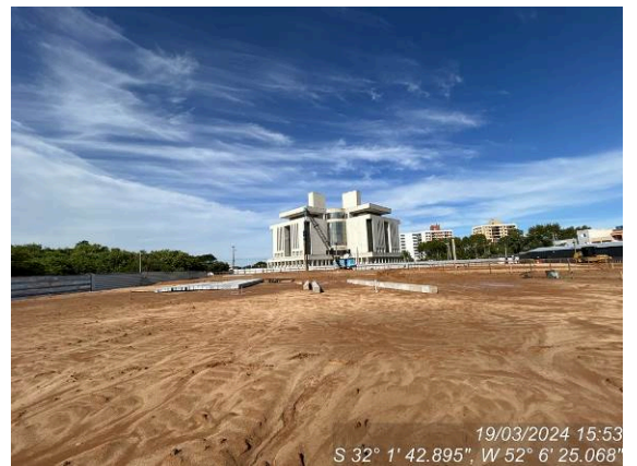
Geral canteiro – execução prejudicada pós ocorrência de chuva
