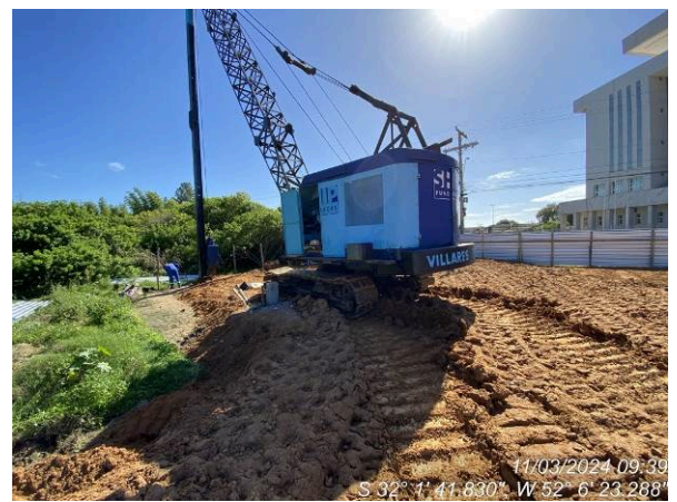
Início da execução do estaqueamento
