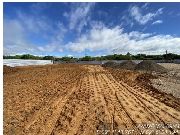
Aterro de sobrecarga
