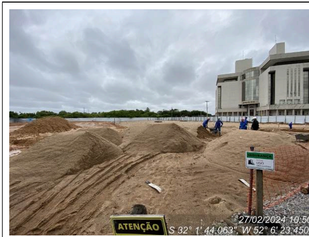
Execução manual do colchão de areia
