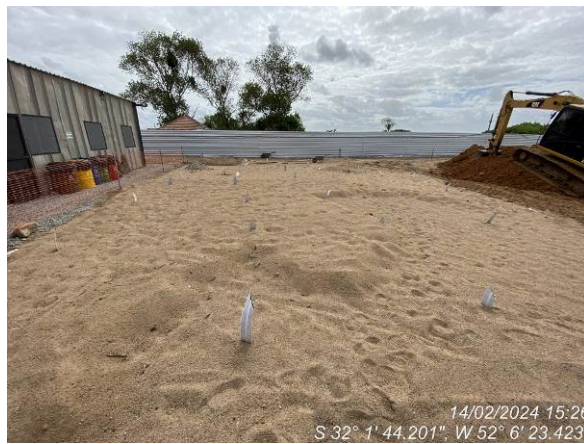
Colchão de areia
