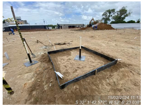
Placa de recalque instalada sobre base elevada de colchão de areia
