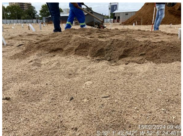
Execução de base no nível correto do colchão de areia para instalação das placas de monitoramento do recalque
