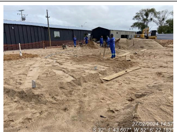
Execução manual do colchão de areia
