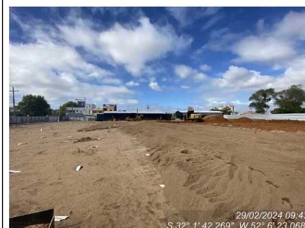
Colchão de areia
