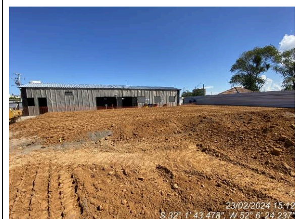
Aterro de sobrecarga
