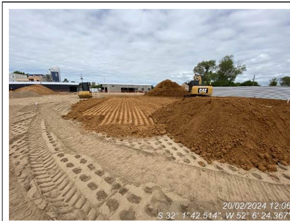
Execução do aterro de sobrecarga
