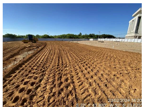
Aterro de sobrecarga
