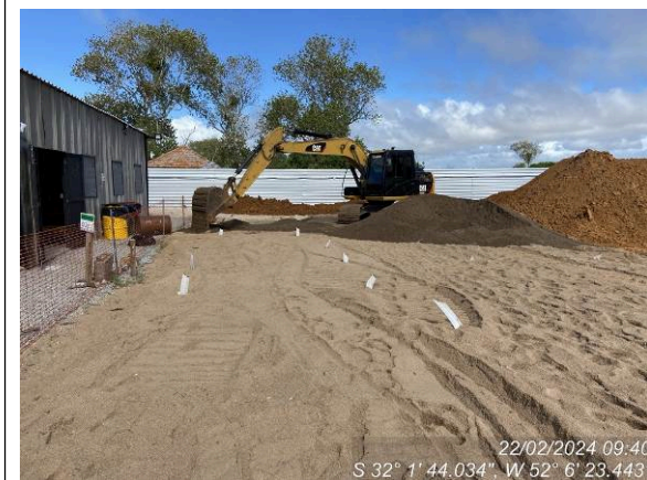
Execução do colchão de areia
