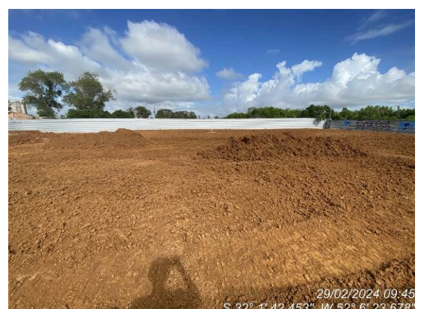
Aterro de sobrecarga
