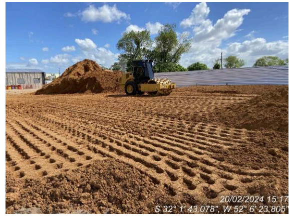
Execução do aterro de sobrecarga
