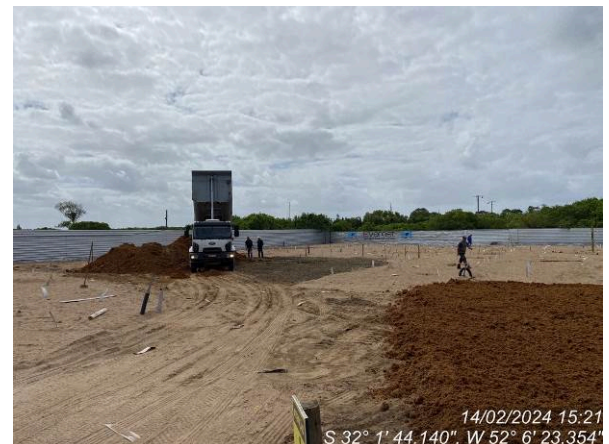
Geral canteiro – depósito de material do aterro
