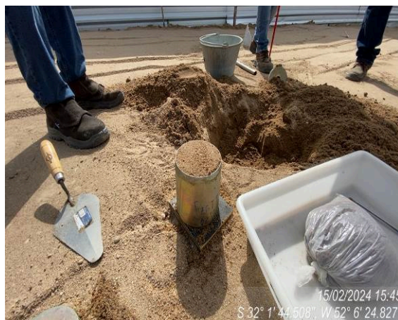
Ensaio de compactação do colchão de areia executado pela CERM
