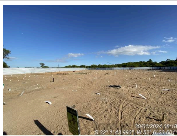
Geral canteiro – serviços paralisados
