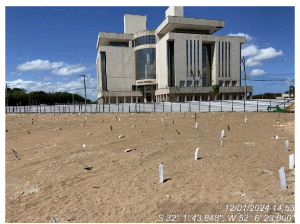
Geral canteiro – serviços paralisados
