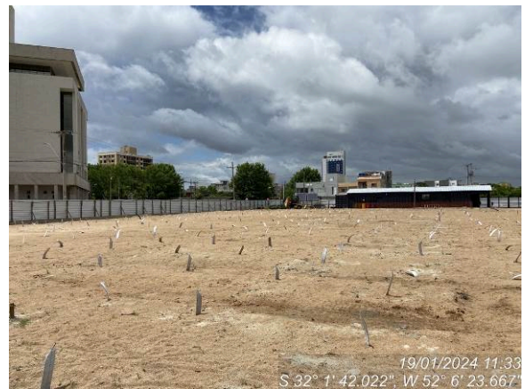
Geral canteiro – serviços paralisados
