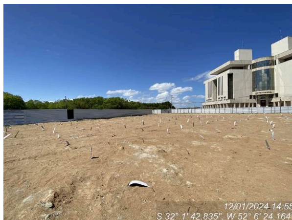
Geral canteiro – serviços paralisados
