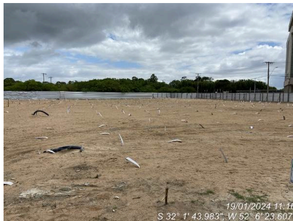
Geral canteiro – serviços paralisados
