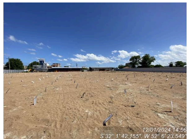
Geral canteiro – serviços paralisados
