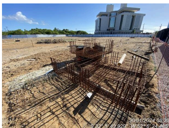
Armaduras dos blocos de fundação – único serviço executado durante o mês de janeiro.
