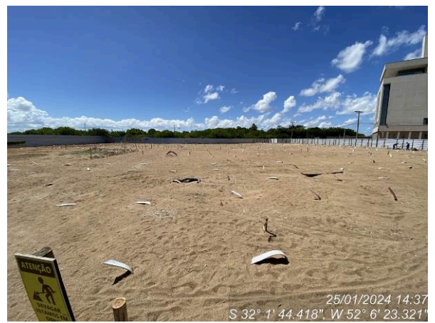
Geral canteiro – serviços paralisados
