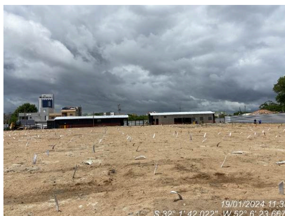
Geral canteiro – serviços paralisados
