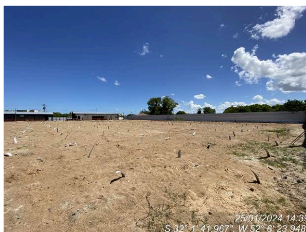
Geral canteiro – serviços paralisados
