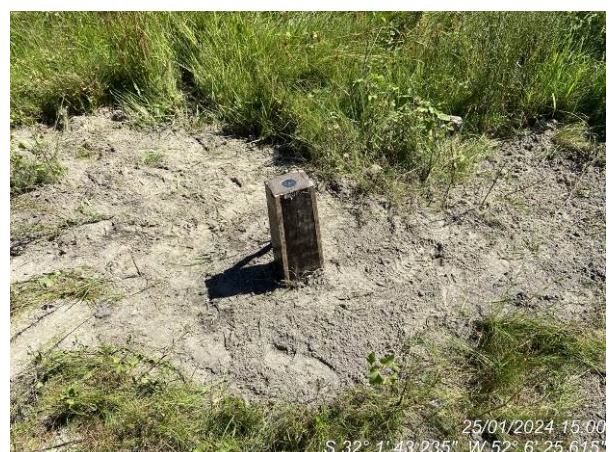
Marcos topográficos executados (CERM)
