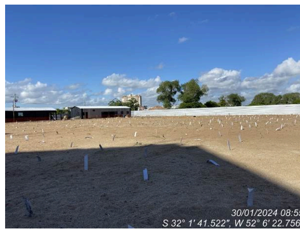
Geral canteiro – serviços paralisados
