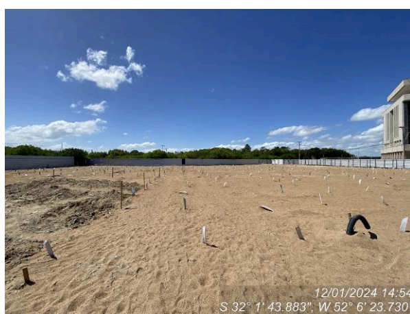
Geral canteiro – serviços paralisados
