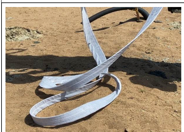
Quantidade de geodreno que não fica no solo após o retorno da lança
