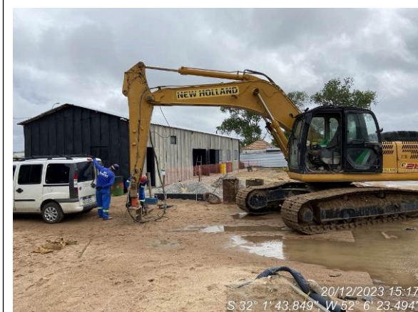
Preparação do equipamento para executar o pré-furo
