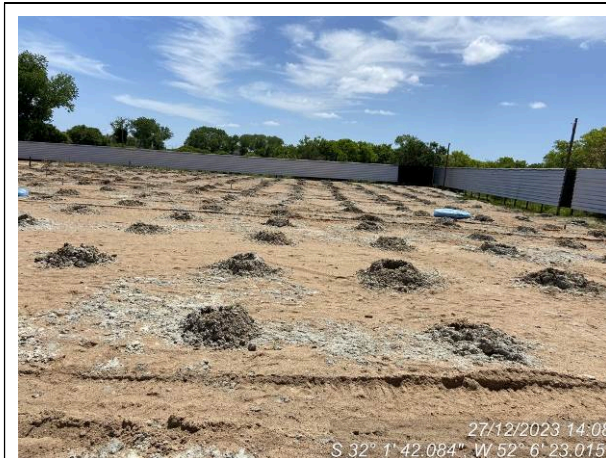
Pré furos para execução dos geodrenos
