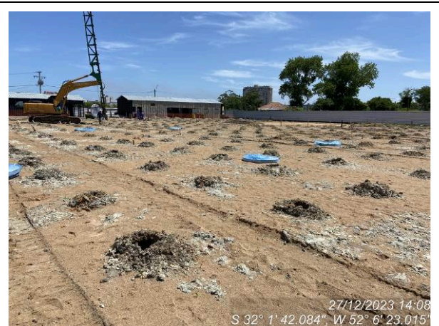
Execução dos geodrenos
