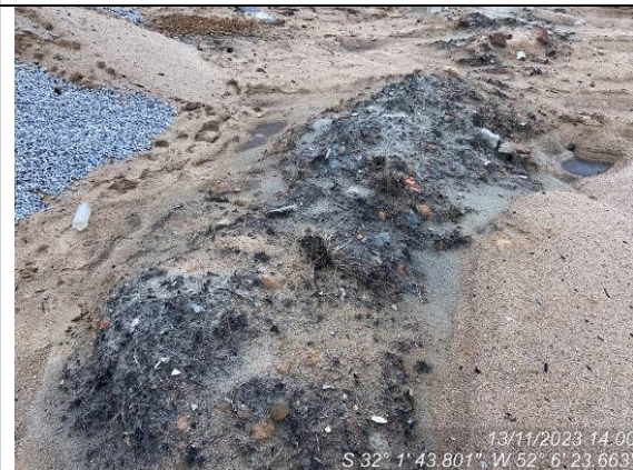
Dia 13/11 – Material de origem vegetal escavado durante execução da drenagem subsuperficial
