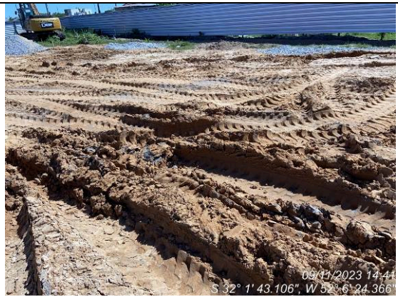
Dia 09/11 – Aterro de regularização não previsto no projeto de adensamento
