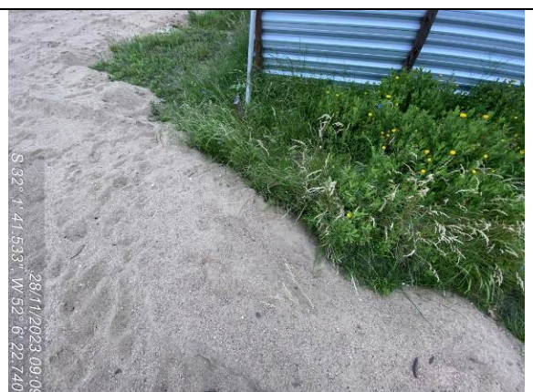
Dia 28/11 – Colchão de areia lançado sobre material vegetal
