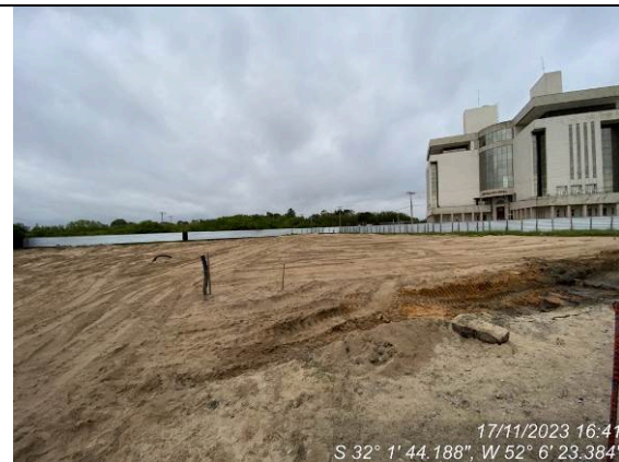
Dia 17/11 – Geral canteiro
