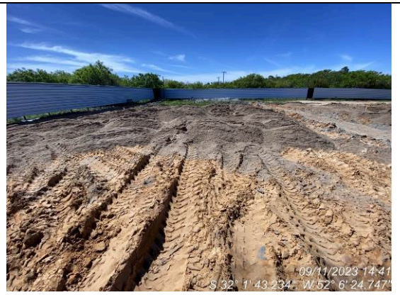
Dia 09/11 – Areia lançada sobre aterro
