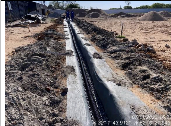
Dia 07/11 – Execução drenagem subsuperficial
