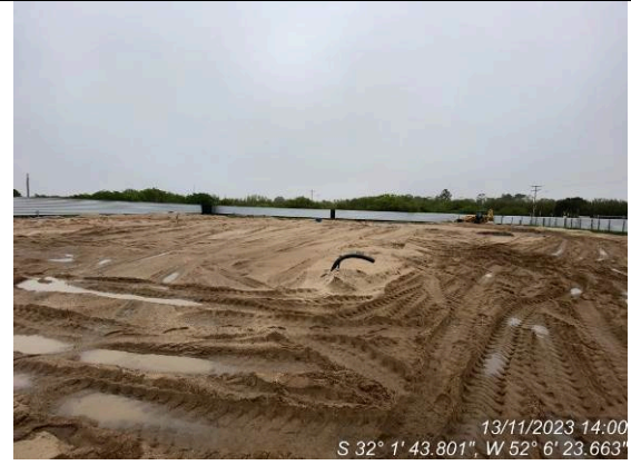
Dia 13/11 – Geral canteiro de obra
