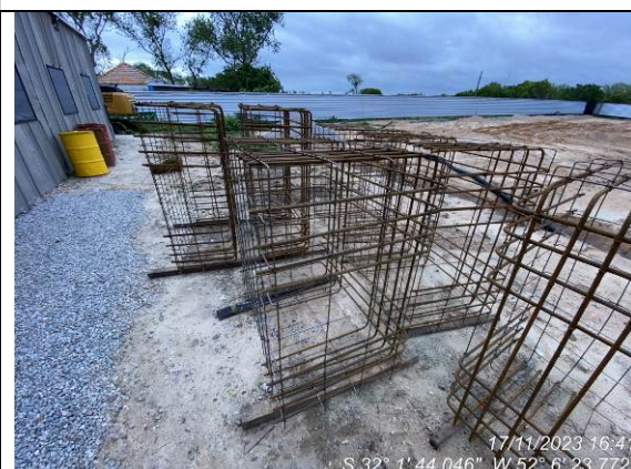
Dia 17/11 – Armaduras blocos de fundação
