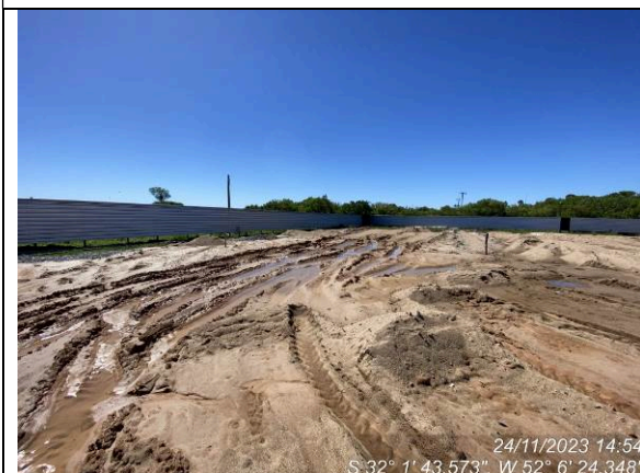
Dia 24/11 – Aterro com muita água acumulada – consistência de lama na presença de água
