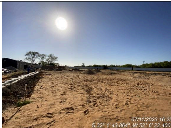
Dia 07/11 – Cargas para colchão de areia apenas estocadas no canteiro
