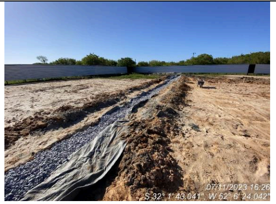
Dia 07/11 – Execução drenagem subsuperficial
