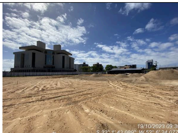
Dia 19/10 – Geral canteiro – Regularização e colchão de areia paralisados.
