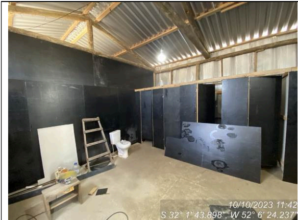
Dia 10/10 – Instalações provisórias
