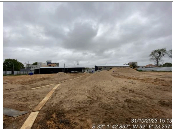
Dia 31/10 – Material para o colchão de areia acumulado – serviço paralisado durante todo o mês.
