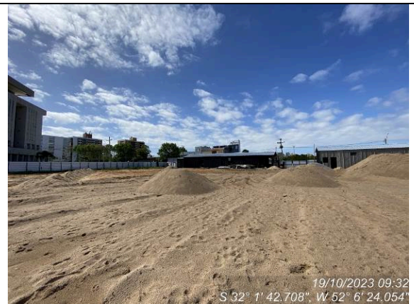
Dia 19/10 – Material para o colchão de areia acumulado – serviço paralisado.
