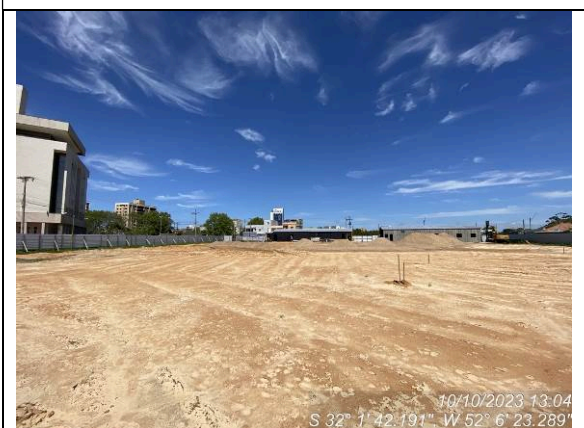
Dia 10/10 – Serviços de regularização e colchão de areia paralisados
