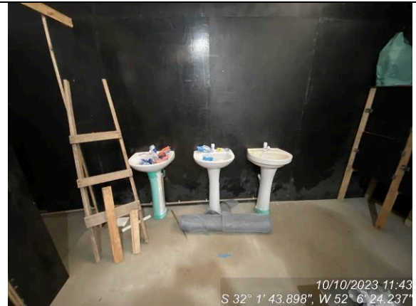
Dia 10/10 – Instalações provisórias
