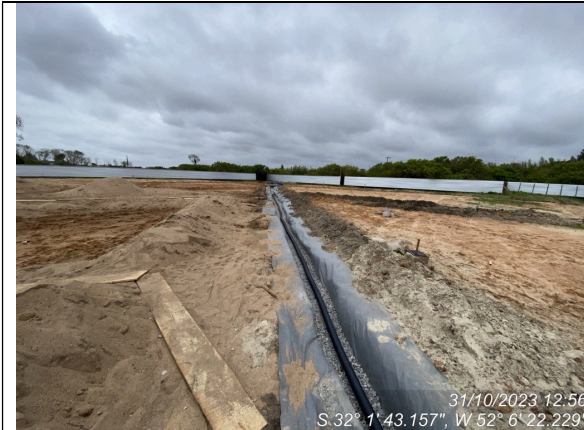
Dia 31/10 – Drenagem subsuperficial – execução em andamento.
