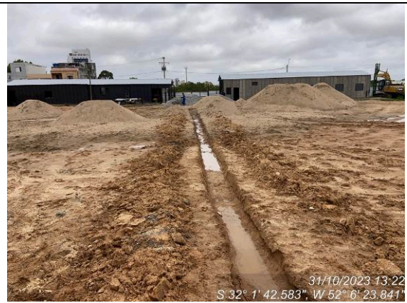
Dia 31/10 – Drenagem subsuperficial – dificuldade de execução devido nível do lençol freático
