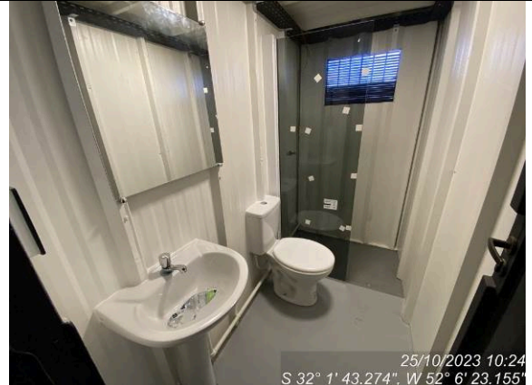
Dia 25/10 – Instalações provisórias – banheiro administração
