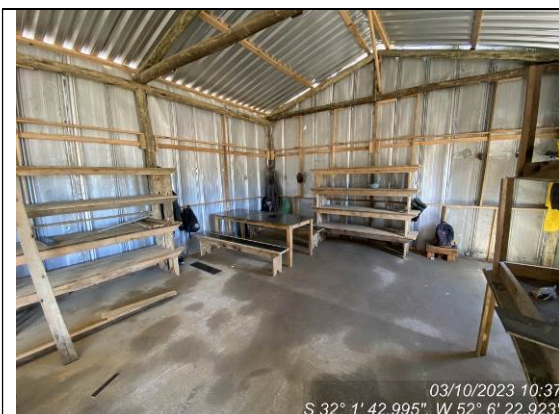
Dia 03/10 – Execução das instalações provisórias
