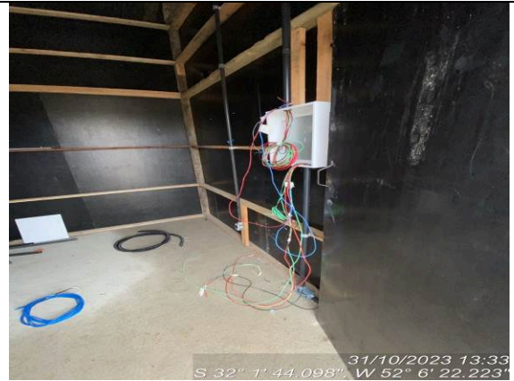
Dia 31/10 – Instalações provisórias - elétrica
