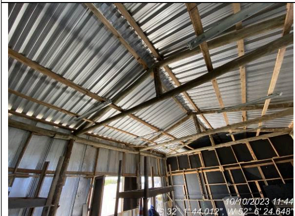
Dia 10/10 – Instalações provisórias
