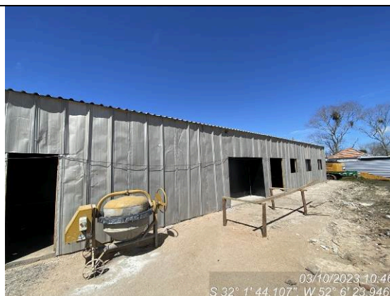
Dia 03/10 – Execução das instalações provisórias
