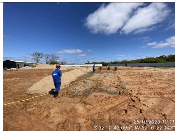
Dia 25/10 – Início drenagem subsuperficial
