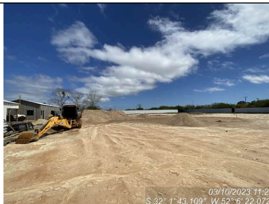
Dia 03/10 – Serviços de colchão de areia paralisado.
