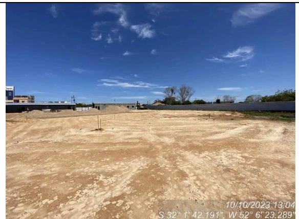
Dia 10/10 – Geral canteiro
