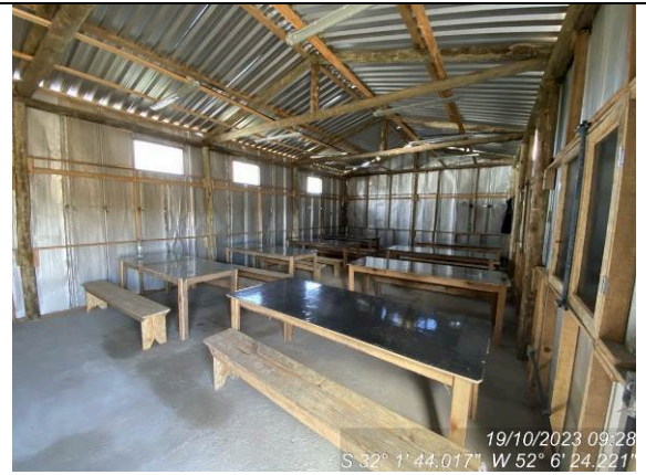
Dia 19/10 – Instalações provisórias
