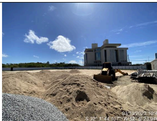
Dia 03/10 – Estoque para execução do colchão de areia
