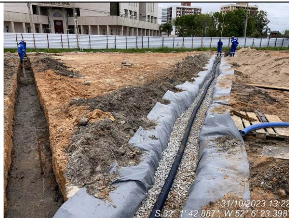
Dia 31/10 – Drenagem subsuperficial – execução em andamento.
