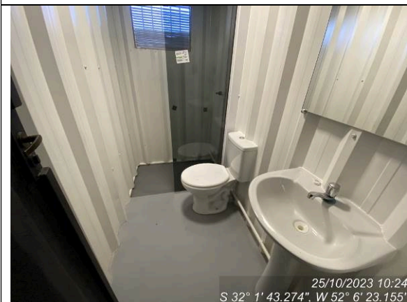
Dia 25/10 – Instalações provisórias – banheiro administração
