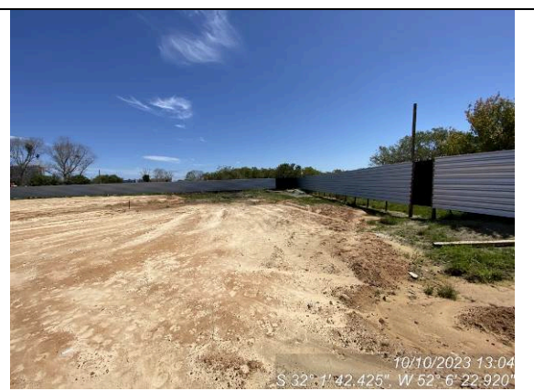
Dia 10/10 – Lado norte do canteiro
