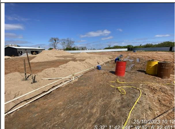
Dia 25/10 – Ponteiras para rebaixamento do lençol freático
