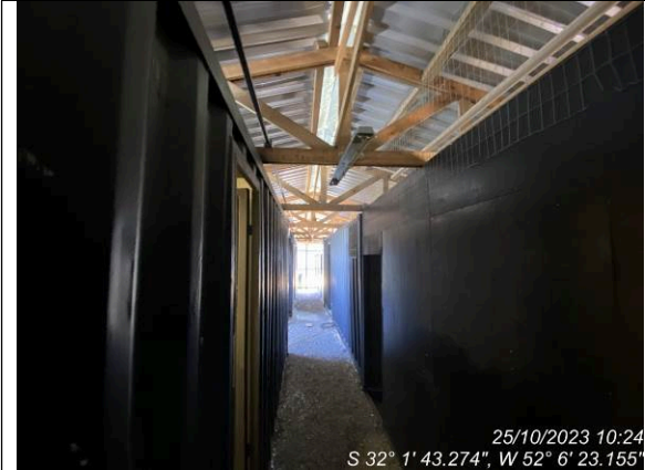
Dia 25/10 – Instalações provisórias
