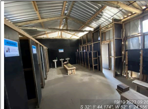
Dia 19/10 – Instalações provisórias
