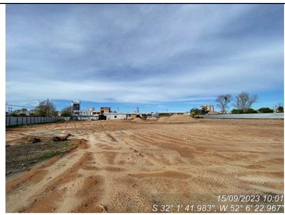
Dia 15/09 – Geral do canteiro
