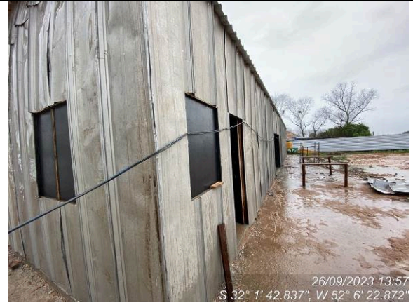
Dia 26/09 – Instalações provisórias
