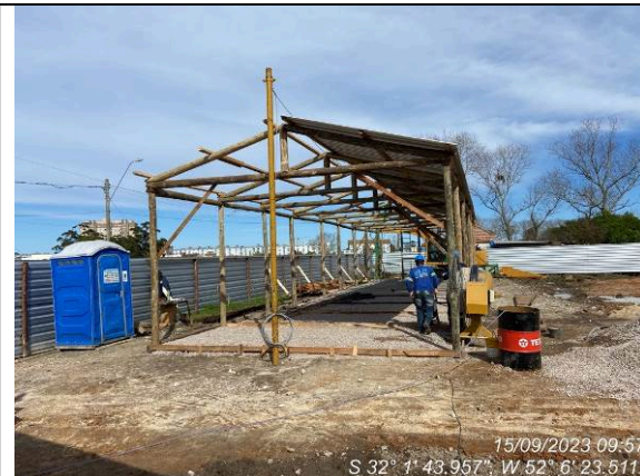
Dia 15/09 – Instalações provisórias
