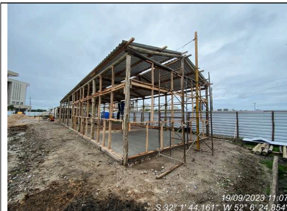
Dia 19/09 – Instalações provisórias
