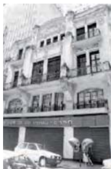
Prédio Rua Gen Camara 264
