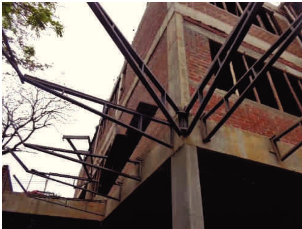
Foto 39 – Visão dos fundos e lateral do prédio
