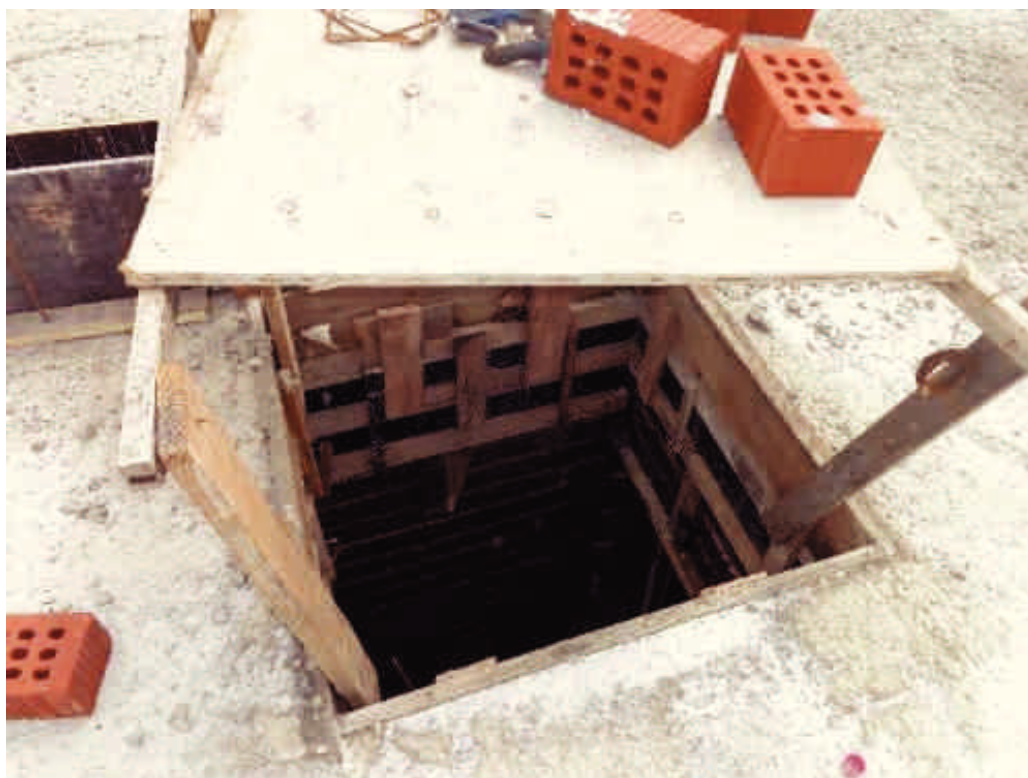
Foto 19 – Laje da cobertura
