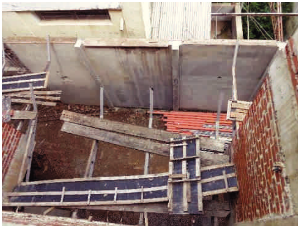
Foto 40 – Estrutura destinada a receber as bandejas salva-vidas
