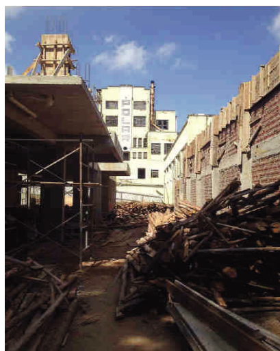
Execução da 1ª Laje sem guarda-corpo
