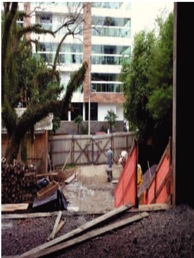
Foto 03 – Visão interna do canteiro. Acesso do canteiro pela Rua Borges de Medeiros
