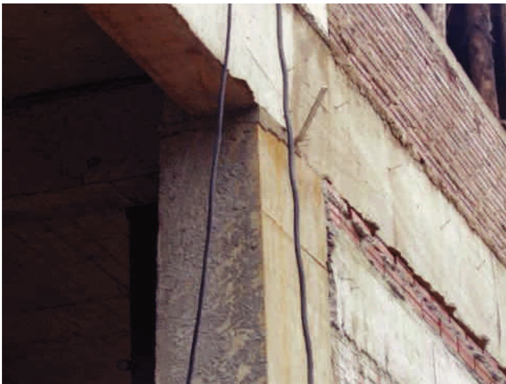
Foto 38 – Vista do re-bar no pavimento térreo
