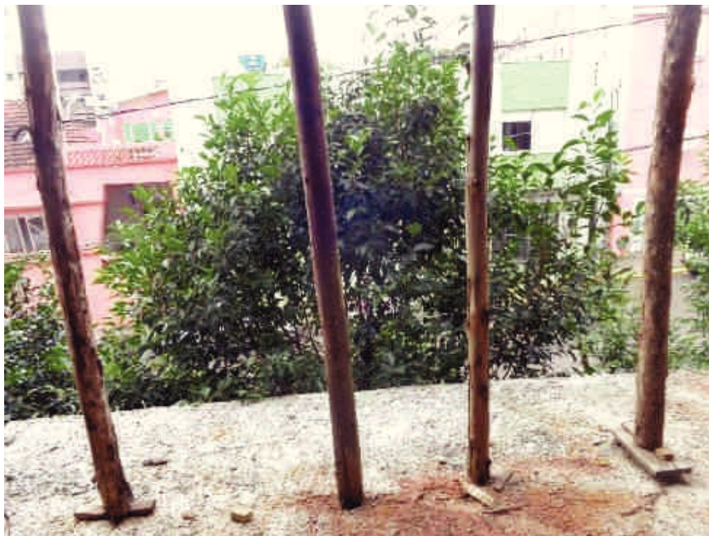
Foto 50 – Laje do segundo pavimento
