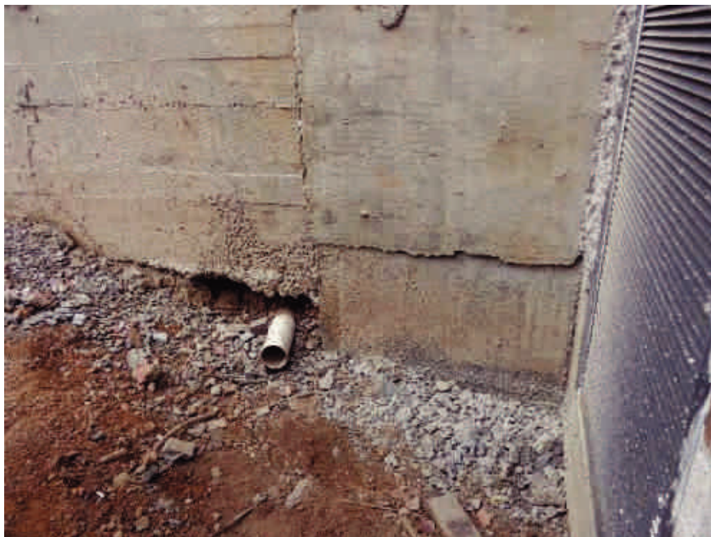
Foto 12 – Subsolo - Instalação do esgoto pluvial
