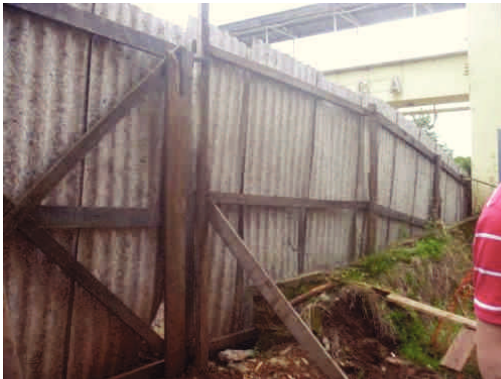
Foto 01 – Canteiro de obra - Tapume para fechamento do canteiro
