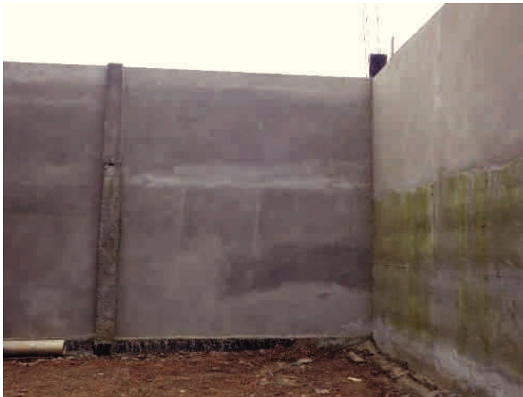
Foto 11 – Muro nos fundos do terreno e cortinas
