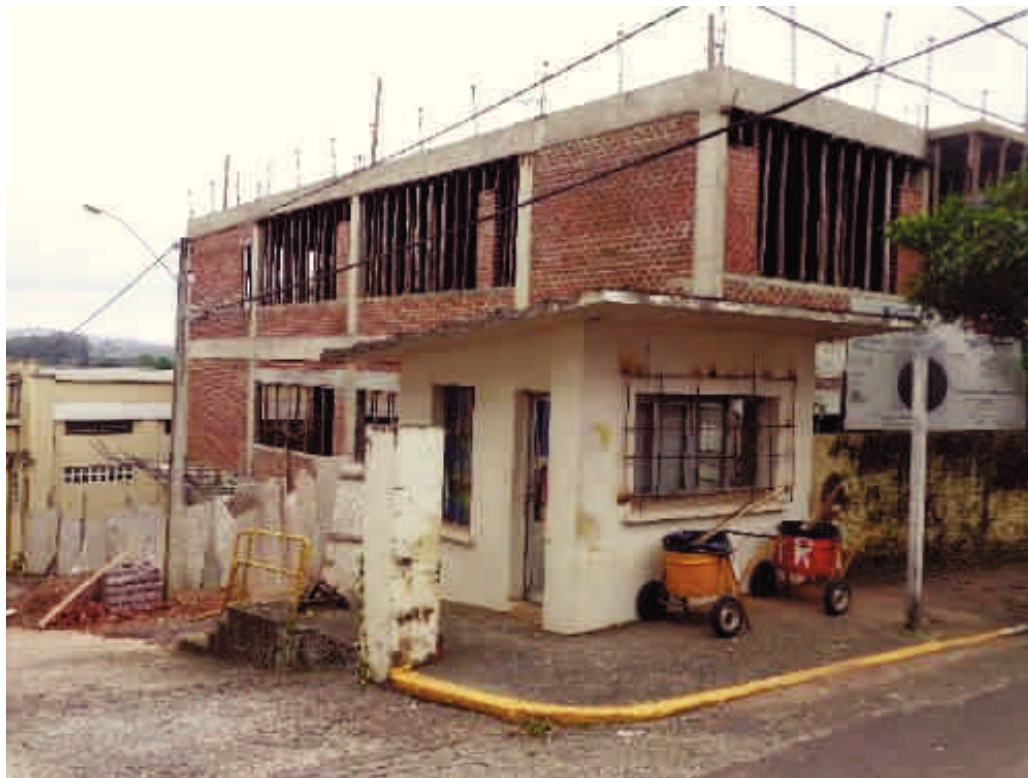
Foto 31 – Guarita a ser demolida
