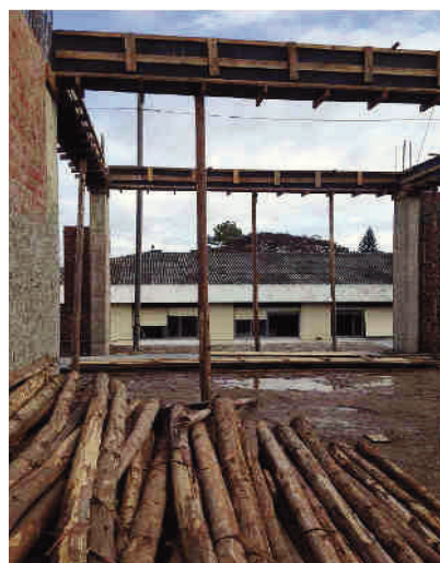
Execução da 2ª laje sem guarda-corpo
