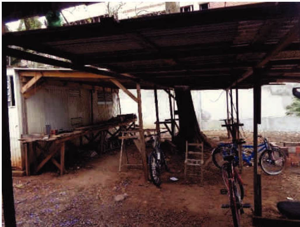
Foto 47 – Telheiro (canteiro de obra)
