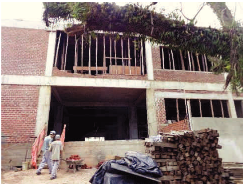
Foto 14 – Vista dos térreo e segundo andar
