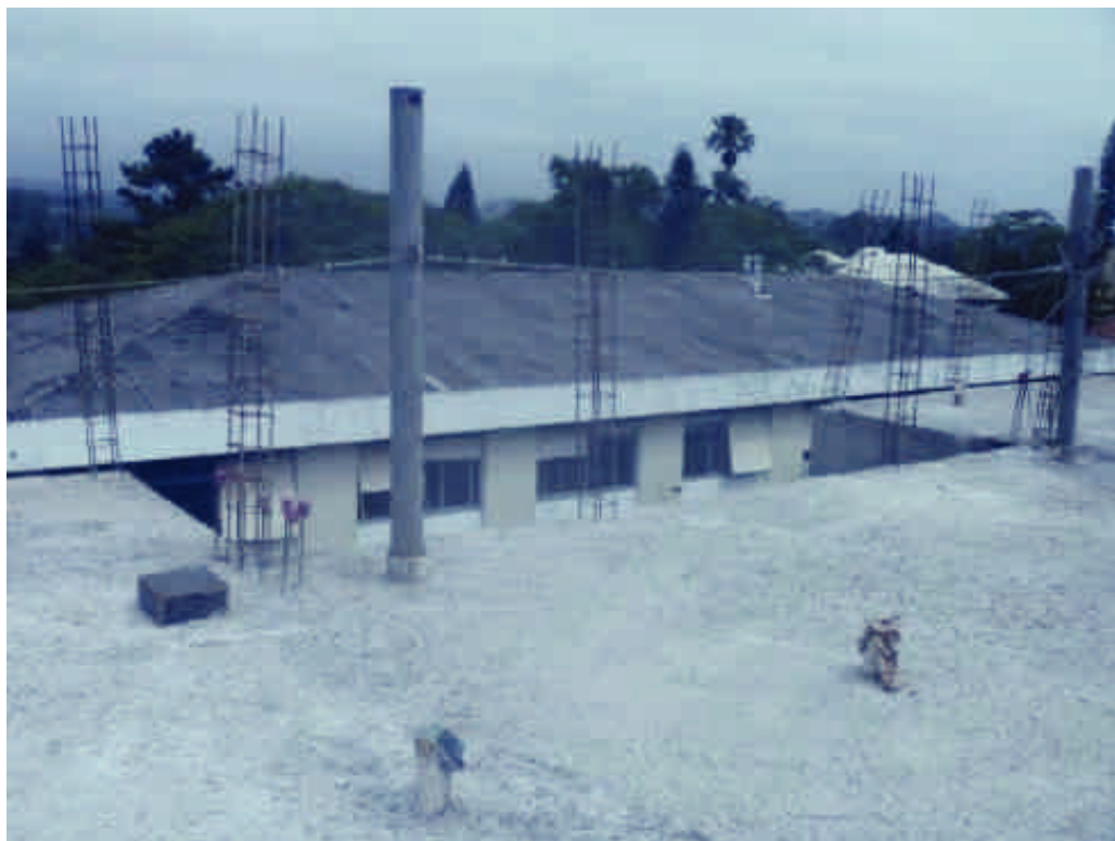
Foto 24 – Cobertura – Armaduras para platibanda
