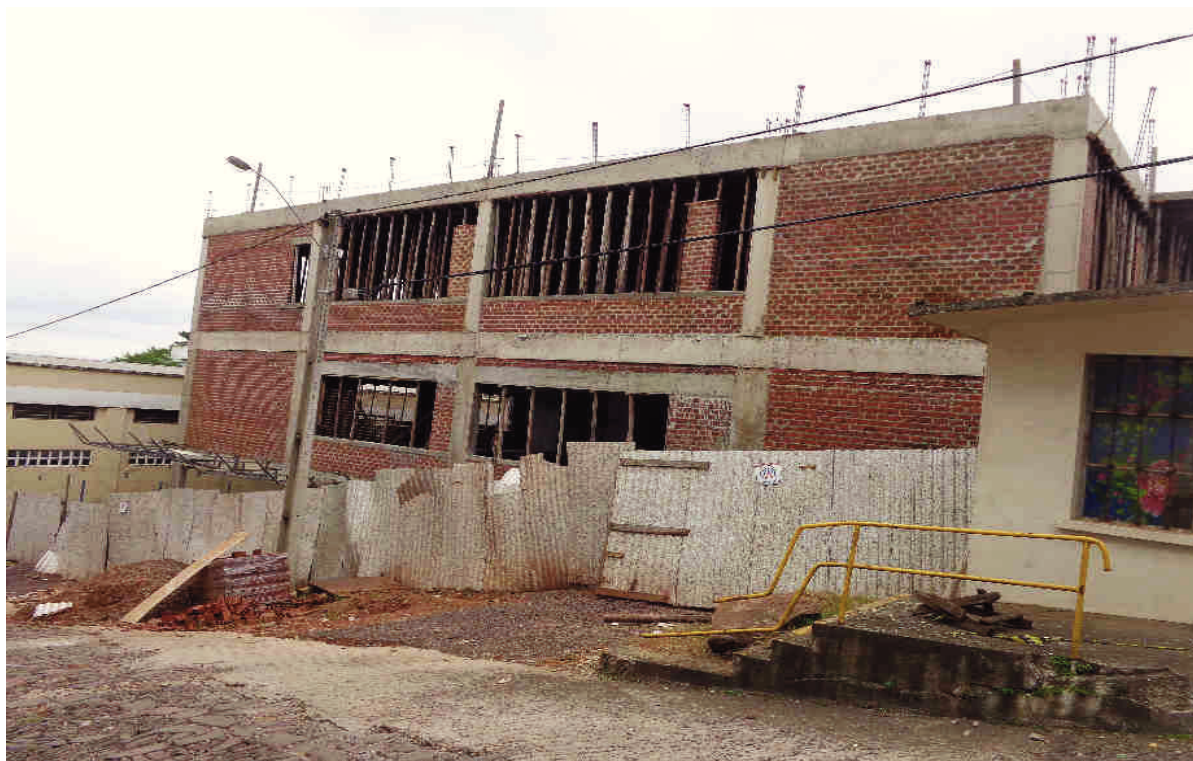
Figura 1 – vista lateral do canteiro de obra.
