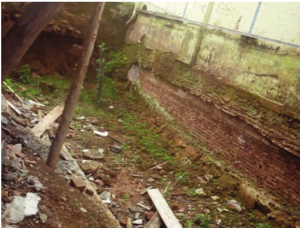
Foto 07 – Espaço destinado para a estação de tratamento de esgoto
