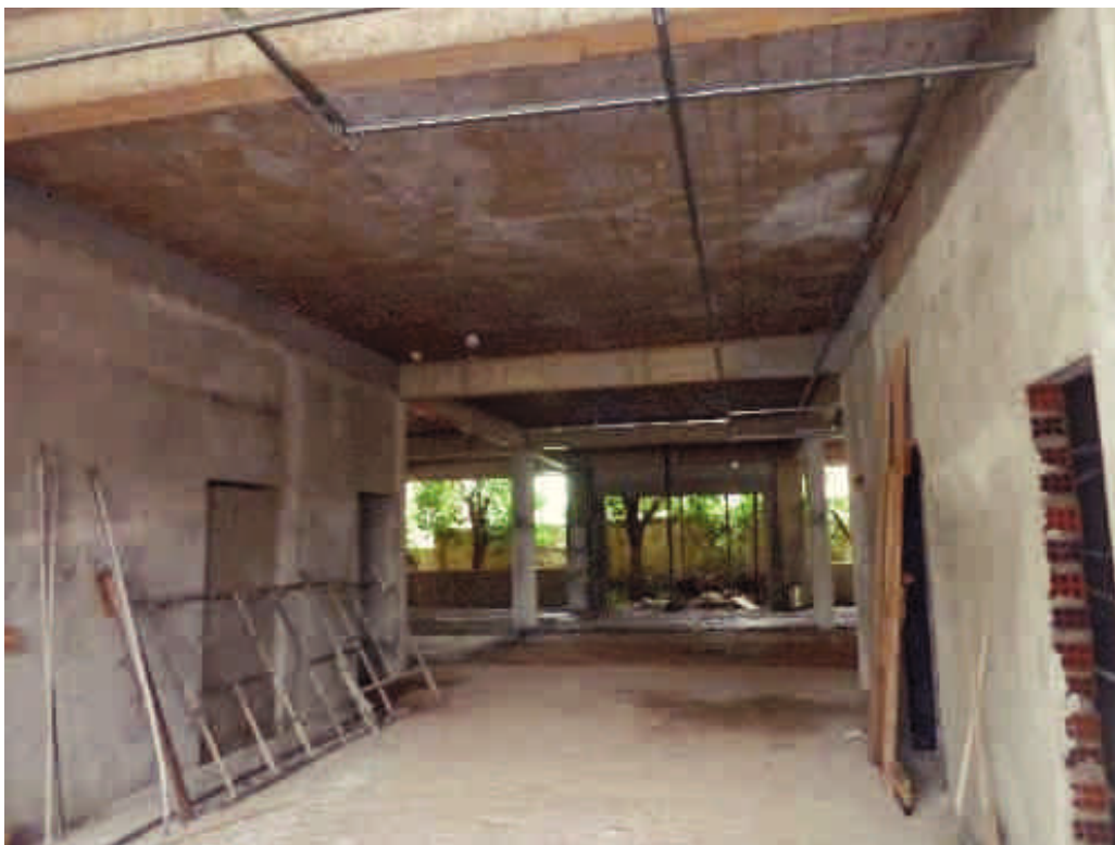
Foto 08 – Pavimento térreo - Acesso aos elevadores
