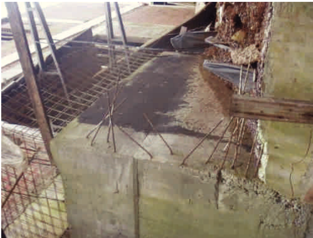
Foto 37 – Saída do duto de ventilação das escadas
