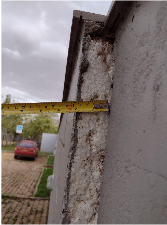
Foto 25 - Detalhe da abertura do muro nos fundos da Vara do Trabalho
