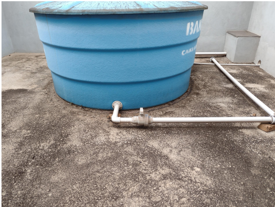
Foto 05 - Cobertura - laje do reservatório
