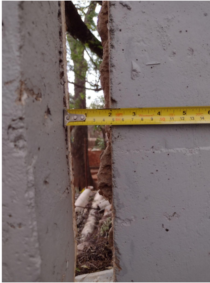
Foto 24 - Detalhe da abertura do muro nos fundos da Vara do Trabalho
