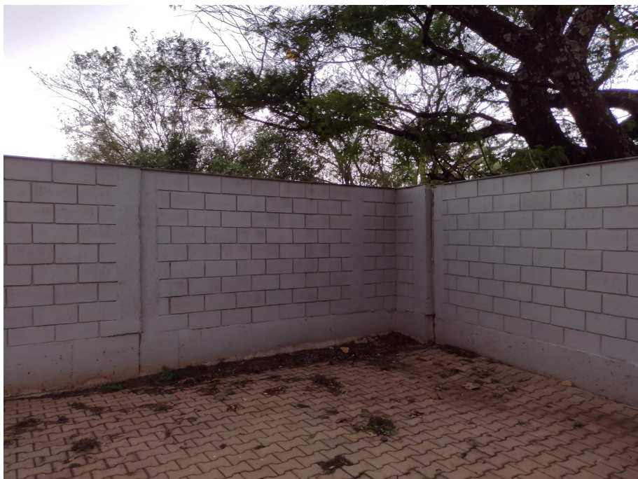
Foto 22 - Muro nos fundos da Vara do Trabalho
