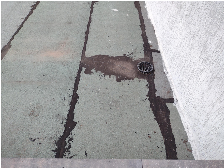
Foto 04 - Cobertura (detalhe do ralo)
