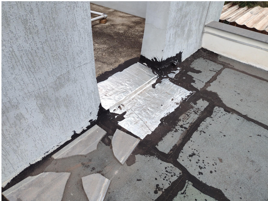
Foto 06 - Cobertura - divisa da área da caixa d'água
