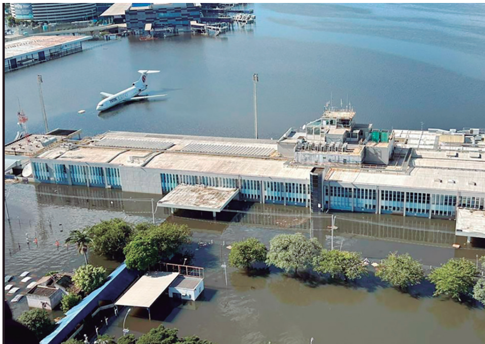
Figura 58 – Prédio da Torre de Controle do Aeroporto Salgado Filho, pátio de estacionamento de aeronaves e pista de pouso inundados.
