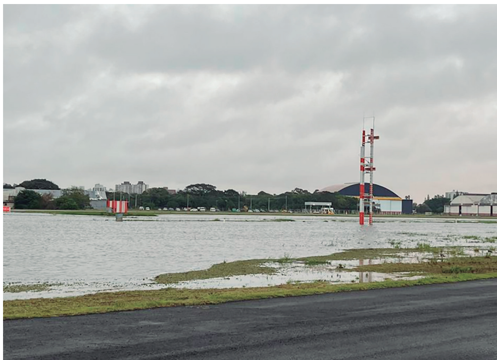
Figura 57 – Início do alagamento no Aeroporto Internacional Salgado Filho, na tarde do dia 03 de maio.
