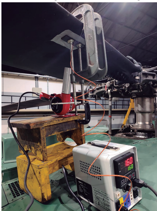
Figura 24 – Estrutura montada para a cura da resina de reparo da trinca da pá.
