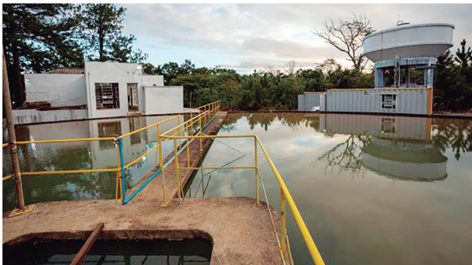
Figura 67 – Estação de Tratamento de Água localizada na BACO.
