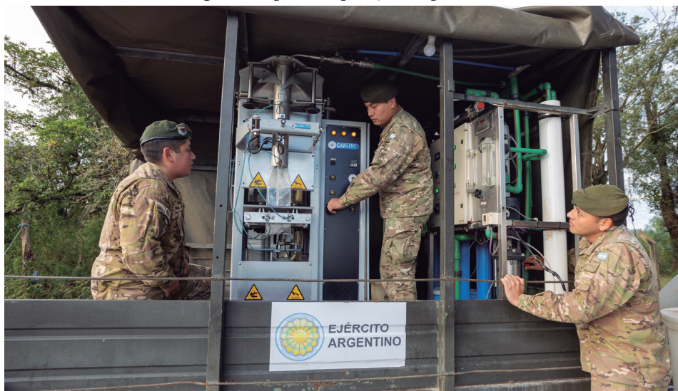
Figura 66 - Pessoal e material do Exército Argentino que trabalhou no processo de tratamento de água em apoio à Operação Taquari II.
