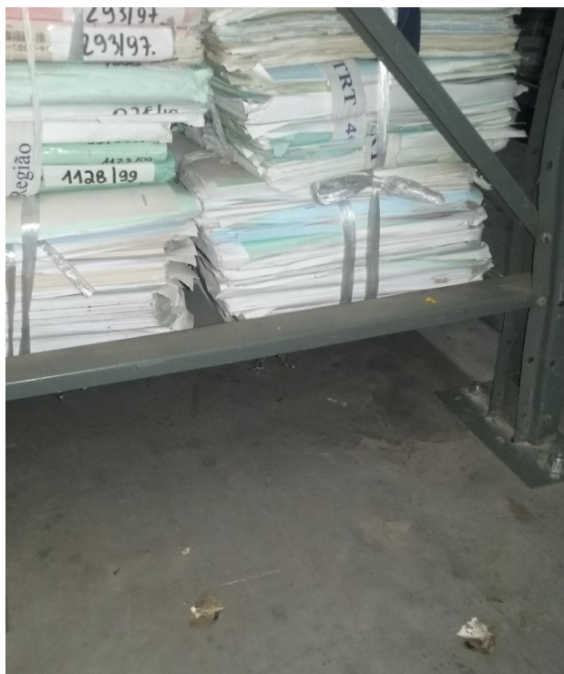
Foto 6: Presença de fezes de pombos no interior dos galpões do Depósito Centralizado
